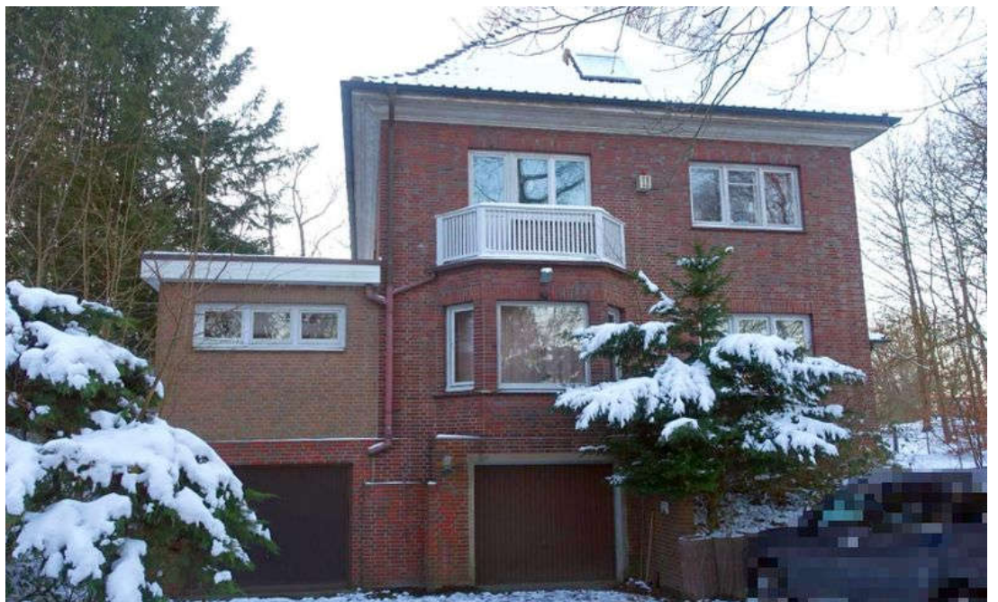
■ | Süd-/Westfassade (Gartenseite) und Ostfassade
