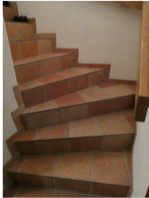
Bild 58: KG Treppe in das EG
