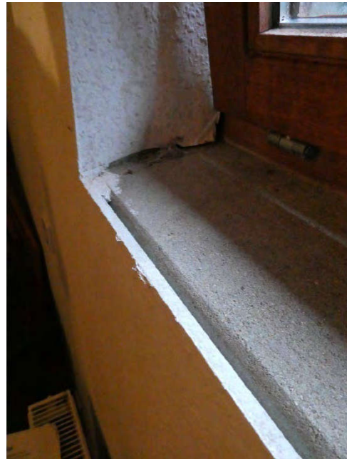
Bild 70: KG Kellerraum Situation Wandputz
