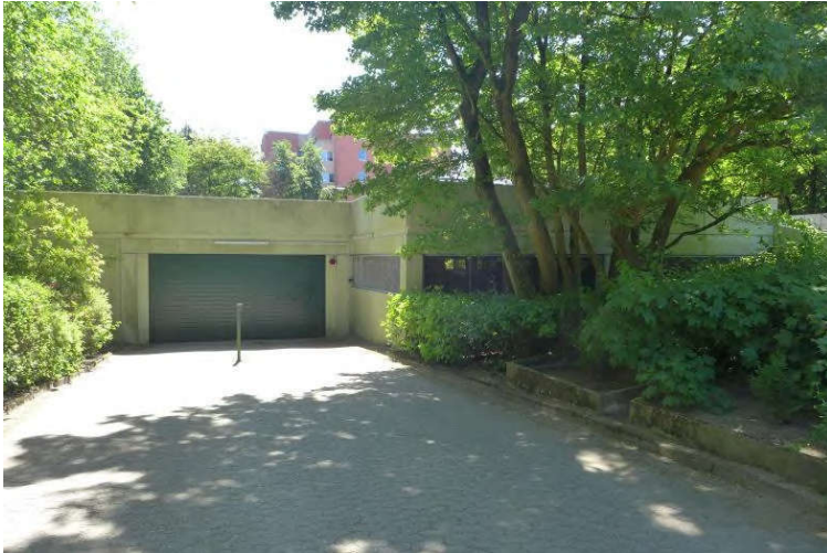
13. Parkgarage auf dem Grundstück
