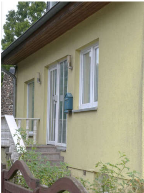
Bild 9: Teilansicht von der Straße mit Eingangsbereich
