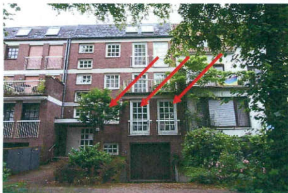
Straßenseite mit Eingangsbereich und Kellergaragenzufahrt (Süd-Osten)
