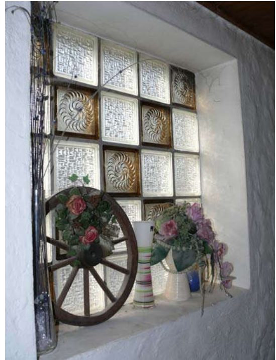
... Glasbausteine zur Belichtung der Eingangsdielen
