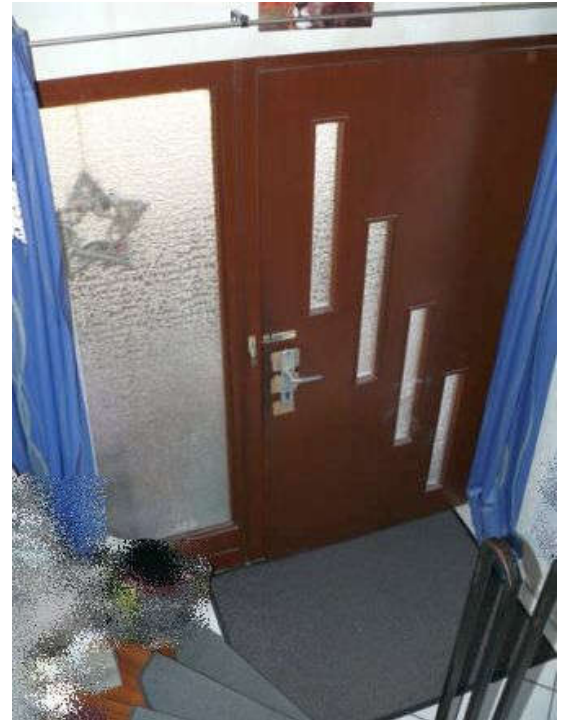
... Hauseingangsbereich - innen - mit Holz-Füllungstürelement (2-teilig)
