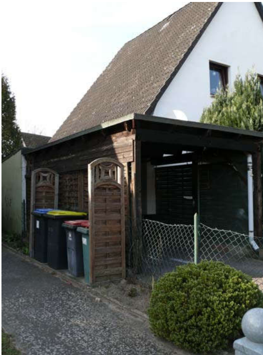
Bild 1: Seitenansicht "Wohnhaus" mit "Carport" und "Garage"
