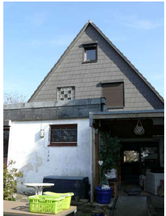
Bild 4: rückwärtiger Anbau mit hölzerner Terrassenüberdachung (Pfosten-Riegel)
