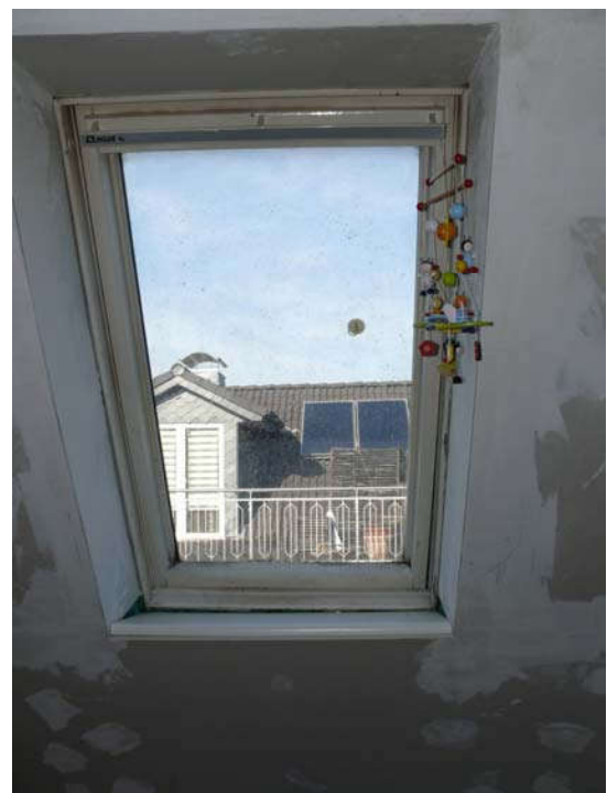
... Holzfenster als Dachflächenfenster (hier: Schwingflügel, Hersteller: Velux)
