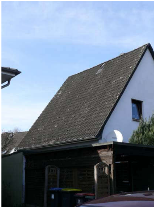
... Haupthaus mit Betondachsteinen
