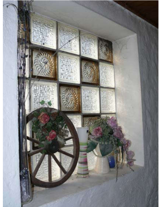
... Glasbausteine zur Belichtung der Eingangsdielen
