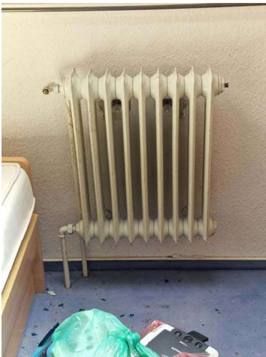
... z.T. als Rippenheizkörper, z.T. Plattenheizkörper
