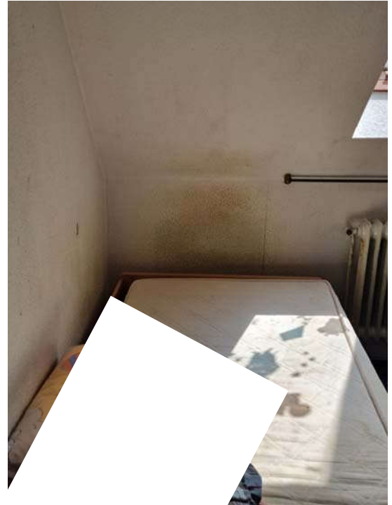
... Renovierungsbedarfe infolge intensiven Verfärbungserscheinungen an Deckenuntersichten und Wandbekleidungen
