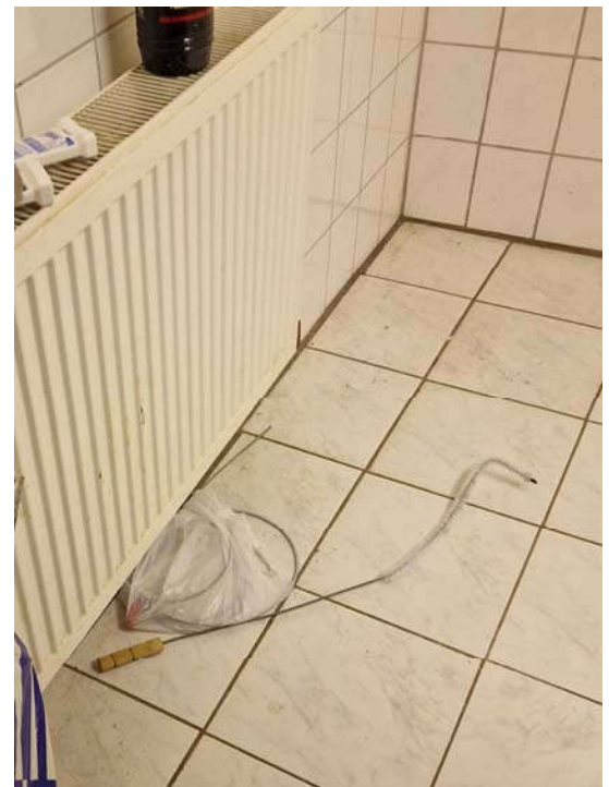
... z.T. als Rippenheizkörper, z.T. Plattenheizkörper
