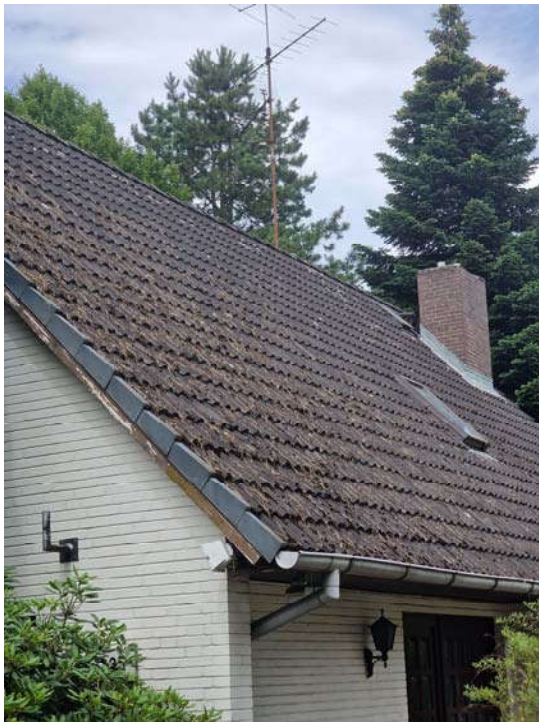
... Satteldach als Sparrendach; Eindeckung mit Betondachsteinen
