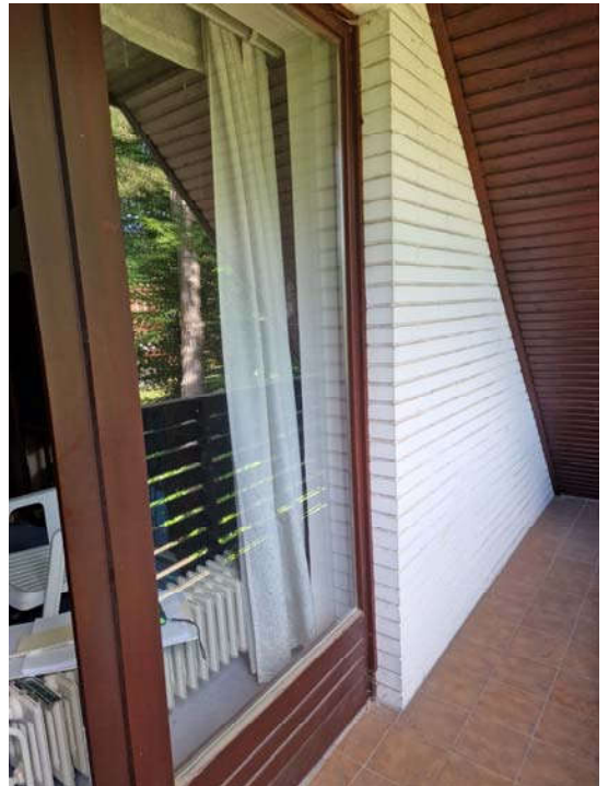
hier: als bodenlanges Loggia-Türfenster-Element im Dachgeschoss (zur Grundstücksrückseite)
