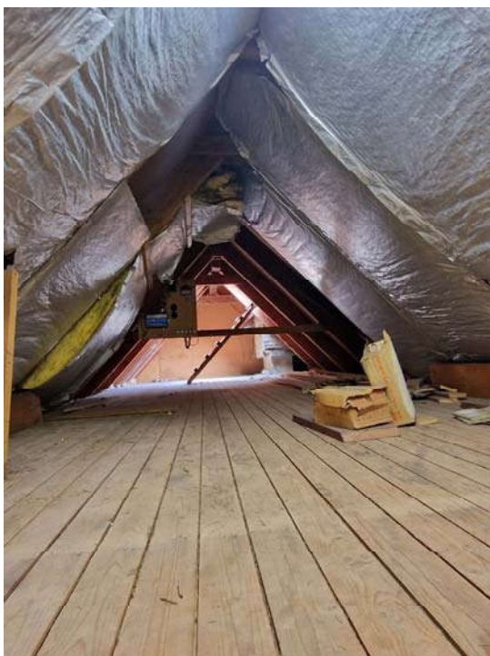
... Kehlbalckenlage (hölzerne Sparrendachkonstruktion mit Wärmedämmung ohne Unterdach)
