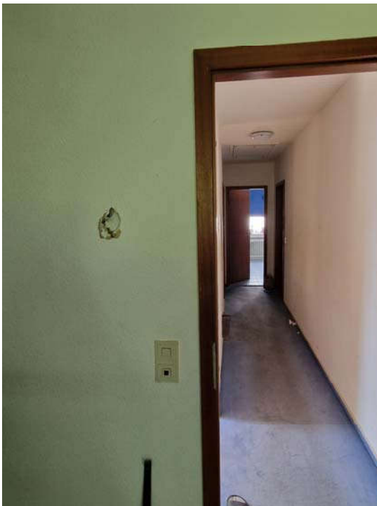
... Instandsetzungsbedarfe bei intensiven Gebrauchsspuren (Beschädigungen an Leichtbau-Innenwänden infolge Vandalismus)
