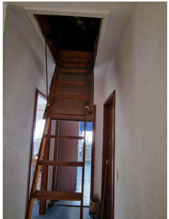
... hölzerne Spitzbodentreppe als Einklapptreppe
