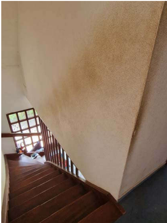
... Renovierungsbedarfe infolge intensiven Verfärbungserscheinungen an Deckenuntersichten und Wandbekleidungen
