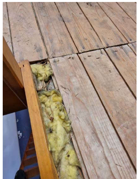
... Kehlbalckenlage (hölzerne Sparrendachkonstruktion mit Wärmedämmung ohne Unterdach)
