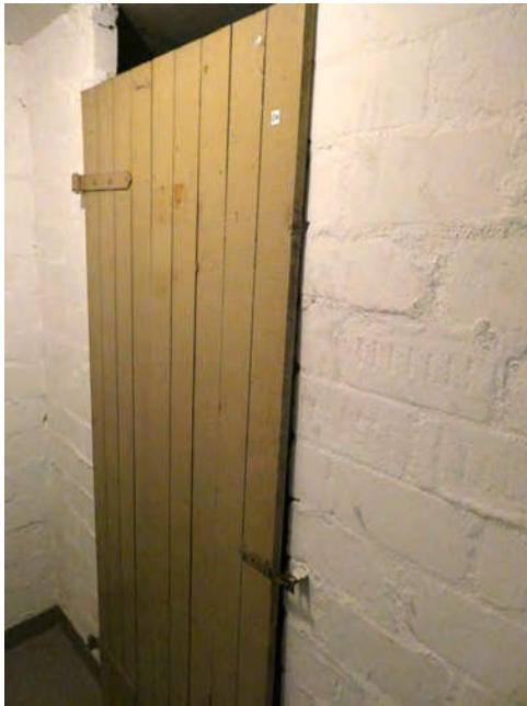
Bild 29: Zugang Kellerraum Nr. 14
