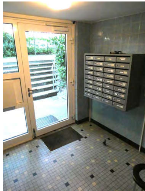
Bild 10: Bereich EG Treppenhaus
