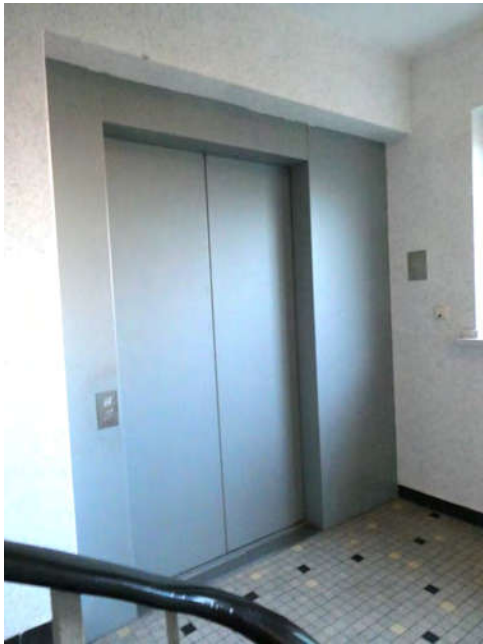
Bild 13: Bereich Treppenhaus / Fahrstuhl
