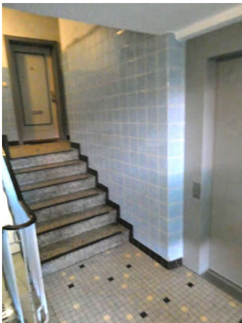
Bild 11: Bereich EG Treppenhaus
