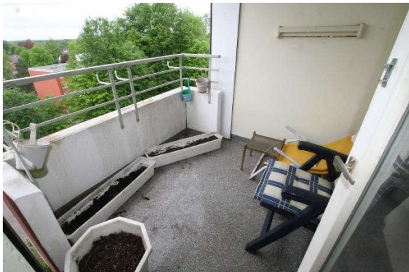
Loggia zur Gebäuderückseite
