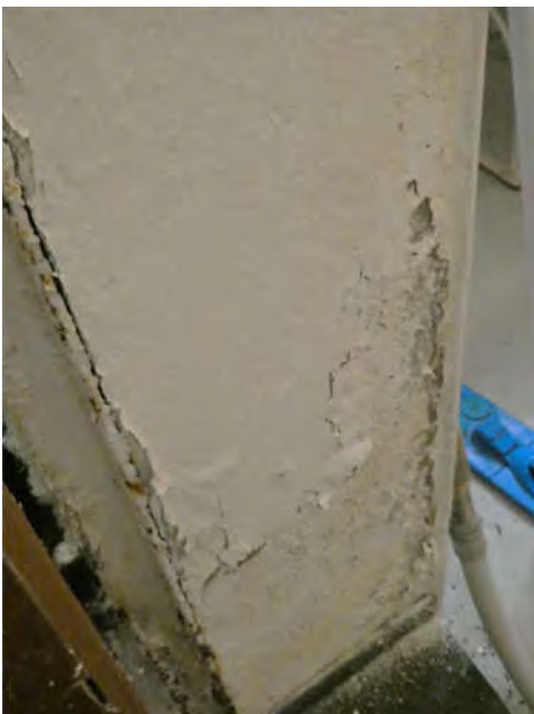
Bild 59: Keller Feuchtigkeitsschaden
