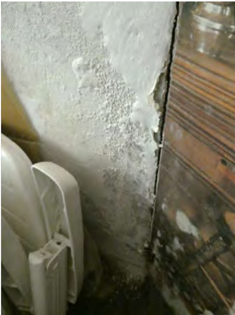
Bild 57: Keller Feuchtigkeitsschaden
