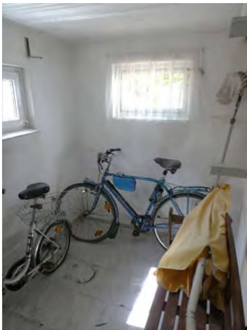
Bild 63: Keller (unterhalb Veranda)
