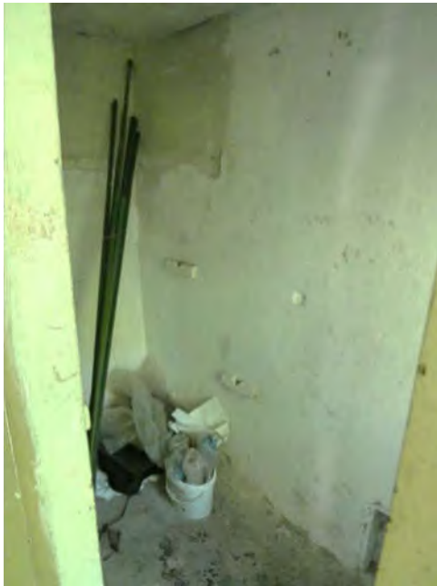
Bild 73: Nebengebäude rückwärtig, Blick in das Gebäude
