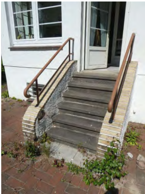
Bild 9: Treppe Veranda rückwärtig
