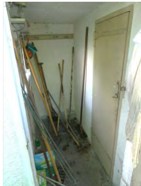
Bild 72: Nebengebäude rückwärtig Blick in das Gebäude
