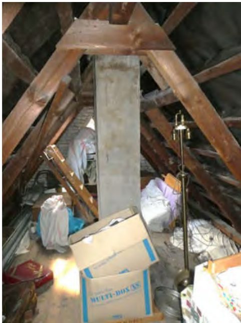
Bild 39: DG Blick in den Spitzboden
