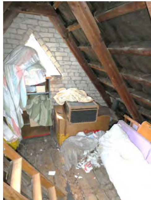
Bild 40: DG Blick in den Spitzboden
