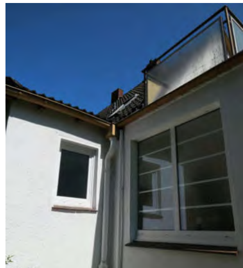
Bild 4: rückwärtige Teilansicht Wohnhaus
