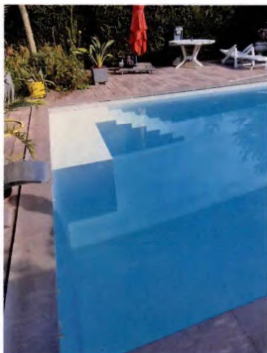
... mit gegossener Einstiegstreppe, Wassersitz und Schwalldusche aus Edelstahl, Beckenbeleuchtung (innen) sowie Beckenrand mit umlaufendem Fliesenrand
