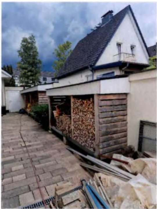
Bild 6: rückseitige Hausumwegung (Südwestseite) und Holzlagerplatz (grenzständige Bauteile)
