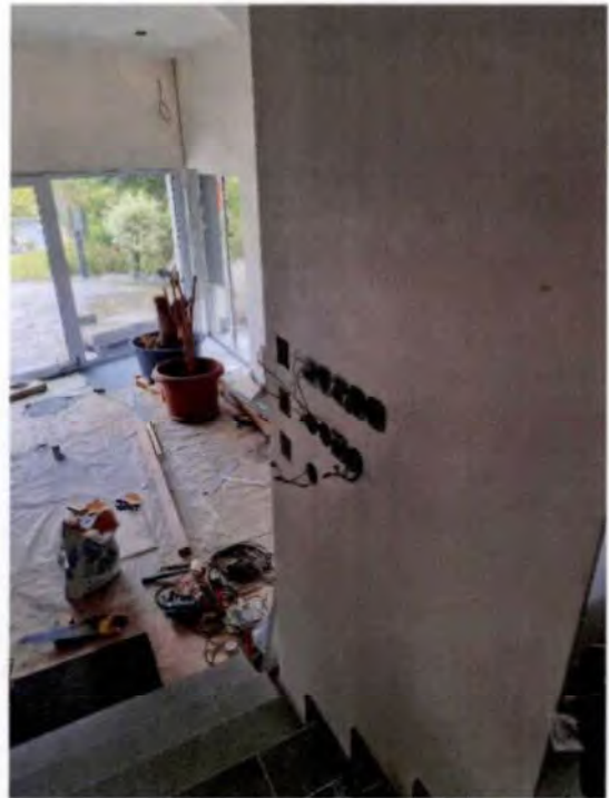
... Niedergang zum Wohnbereich (Erweiterungsbau)
