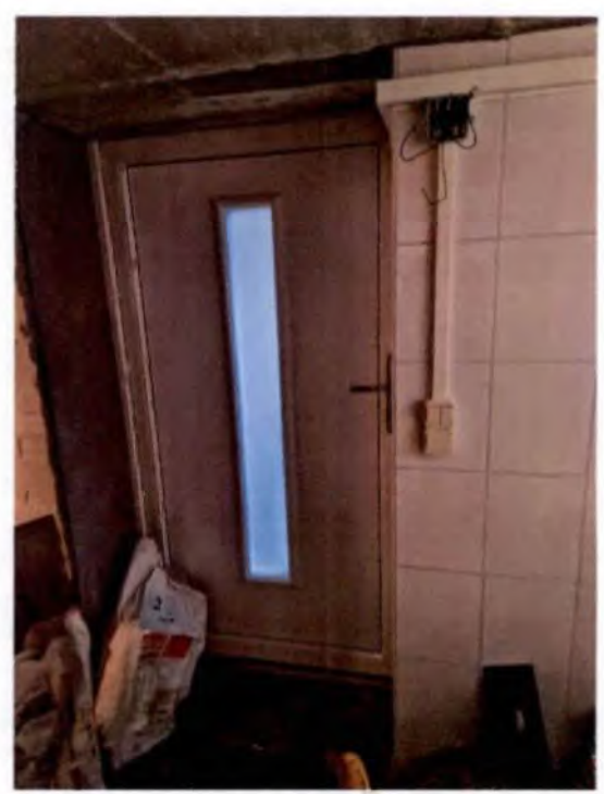
... Außentür im Kellergeschoss "Haupthaus" - innen -
