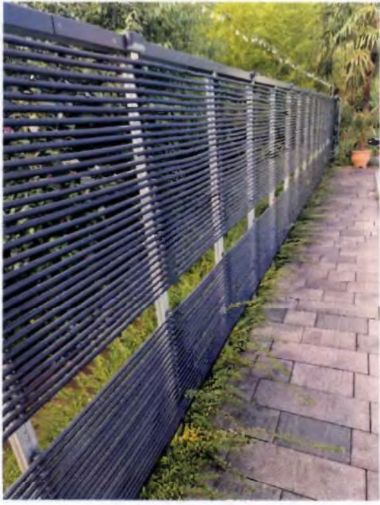
... Solar-Thermie-Heizungsanlage mit Solar-Module
