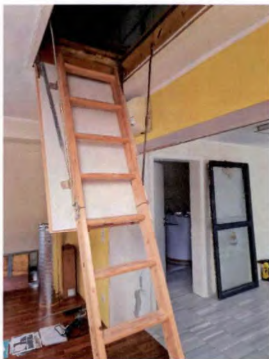
... hölzerne Spitzbodentreppe als Einklapptreppe
