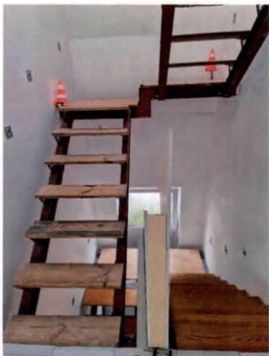
... gegenläufige Treppenanlage mit Podest (unfertig)
