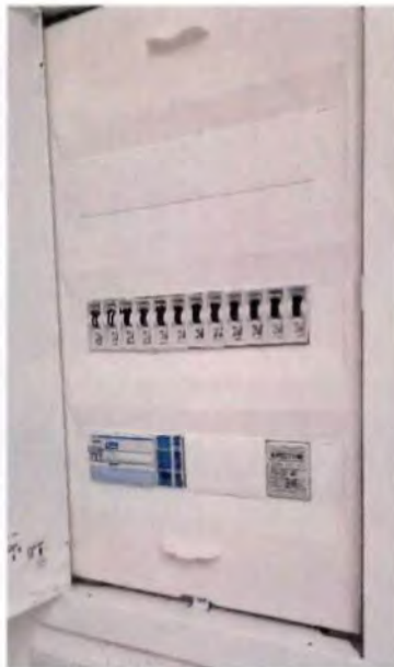
... FI-Kippschalter-Sicherungsautomaten, Zentral-Staubsauger-Anlage und Türöffner mit Gegensprecher und Smart-Home-Steuerung
