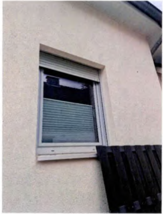
... mit z.T. Einbau-Rollläden (Altbau)
