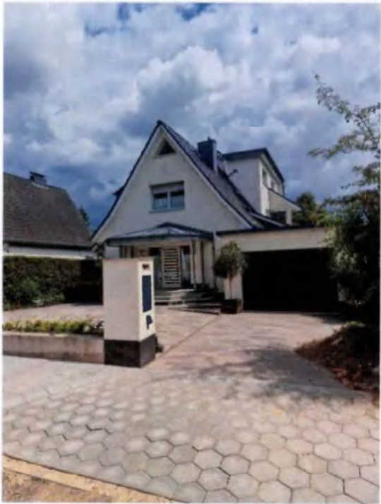
Bild 1: Frontansicht "Haupthaus" mit Garage
