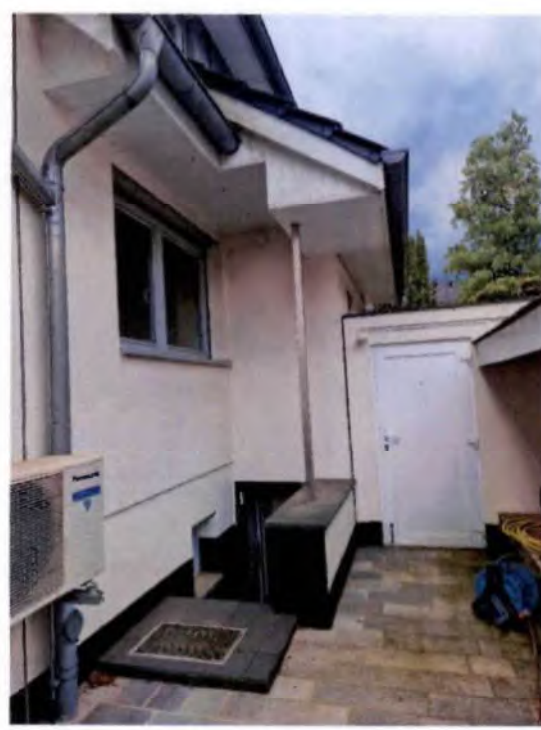
... Kellerniedergang zum Haupthaus
