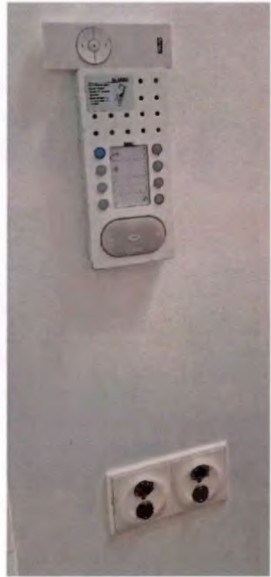
... FI-Kippschalter-Sicherungsautomaten, Zentral-Staubsauger-Anlage und Türöffner mit Gegensprecher und Smart-Home-Steuerung
