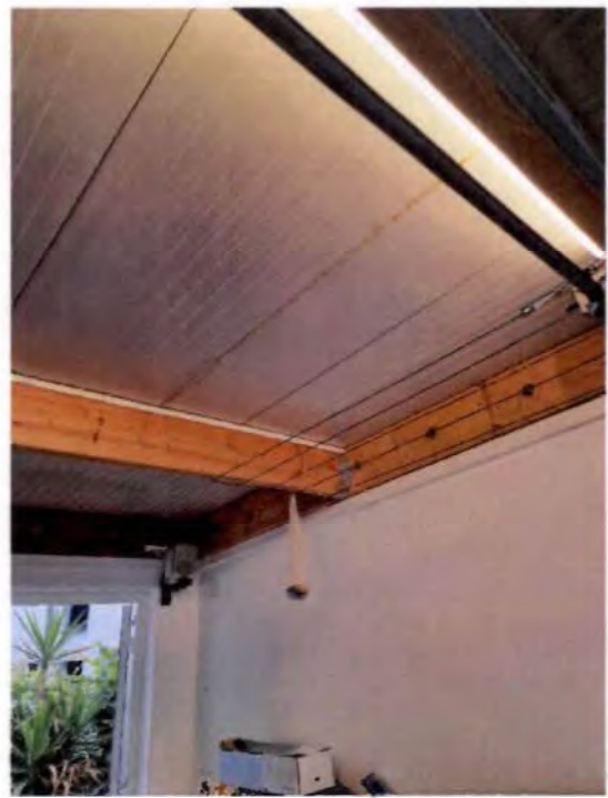
... Deckenbekleidung als abgehängte Decke mit Beleuchtung (indirekt)
