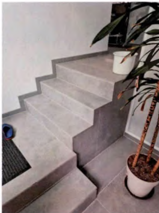
... Eingangstiefland und Treppenaufgang im Erweiterungsbau (auf der Ostseite)
