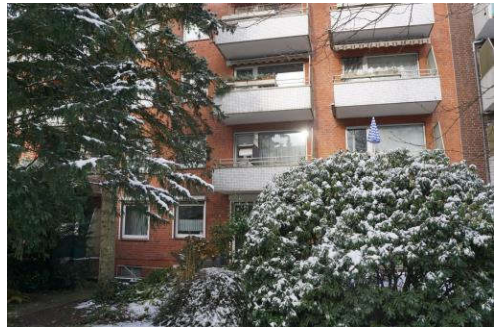
Ansicht hinten mit Detail Balkone
