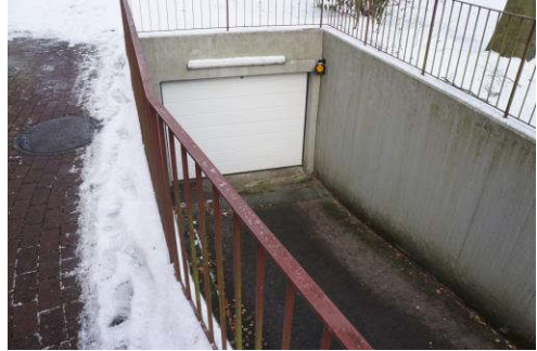
Tiefgaragenzufahrt mit Tor
