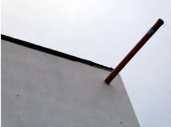
Bild 17: straßenseitige Fassade, Teilansicht, Situation Entwässerung
