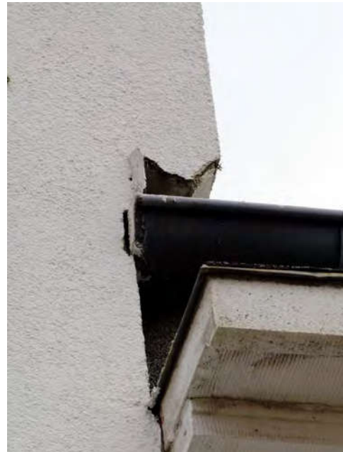
Bild 18: straßenseitige Fassade, Teilansicht, Situation Dachbereich / Fassade
