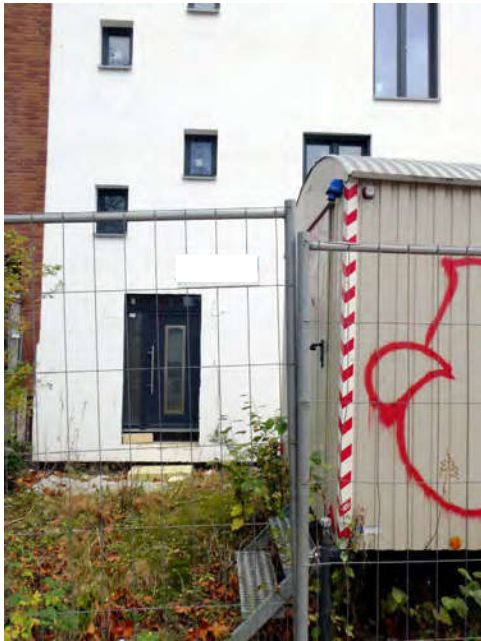
Bild 5: Teilansicht von der Straße
