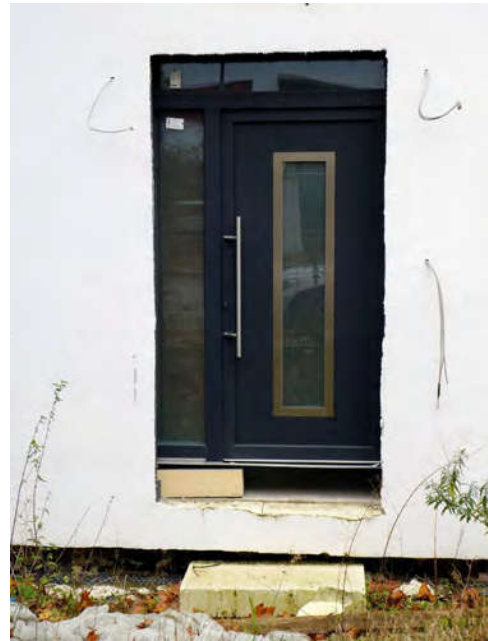
Bild 6: Teilansicht Bereich Gebäudeeingang
