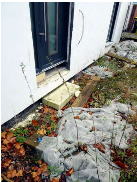
Bild 15: Situation straßenseitige Fassade, Teilansicht Sockel
