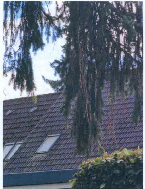
... Dachkonstruktion als hölzerne Pfettendachkonstruktion (als Warmdach mit Unterdach); Eindeckung mit Betondachsteine (Frankfurter Pfanne)
