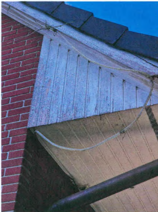
... Dachüberstände (Unterschläge) mit Holzpaneele und Beleuchtung (Spots)
