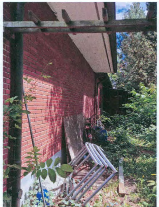
Bild 4: südliche Traufenseite (Erweiterungsbau)
