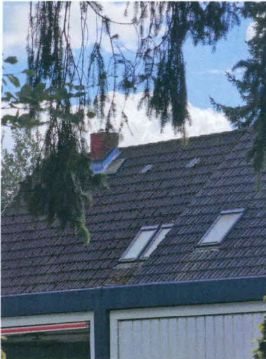
... Dachkonstruktion als hölzerne Pfettendachkonstruktion (als Warmdach mit Unterdach); Eindeckung mit Betondachsteine (Frankfurter Pfanne)
