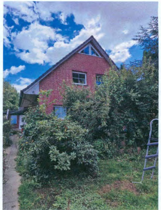
Bild 2: westlicher Hausgiebel (Erweiterungsbau)
