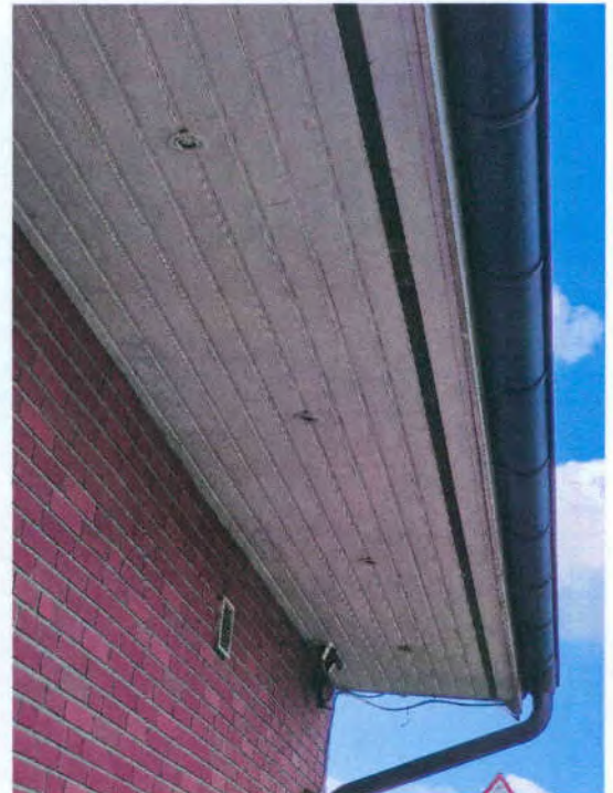
... Dachüberstände (Unterschläge) mit Holzpaneele und Beleuchtung (Spots)
