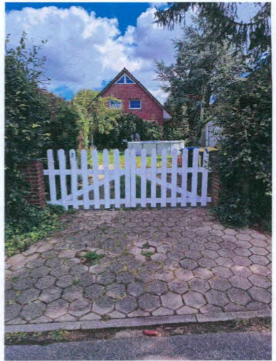
Bild 6: zweiflügeliges Zufahrts-/ Zugangstor (Holztor)
