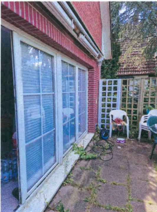
... Kunststofffenster (bodenlanges Terrassenelement) des Erweiterungsbaus
