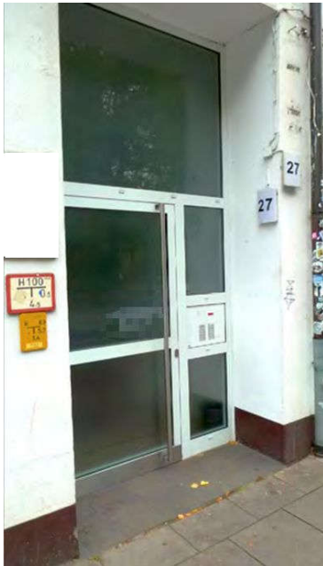
Bild 9: Bereich Hauseingang Nr. 27
