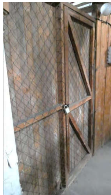
Bild 44: Bereich Dachgeschoss Abstellräume
