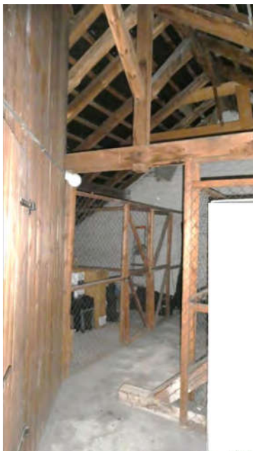
Bild 43: Bereich Dachgeschoss Abstellräume
