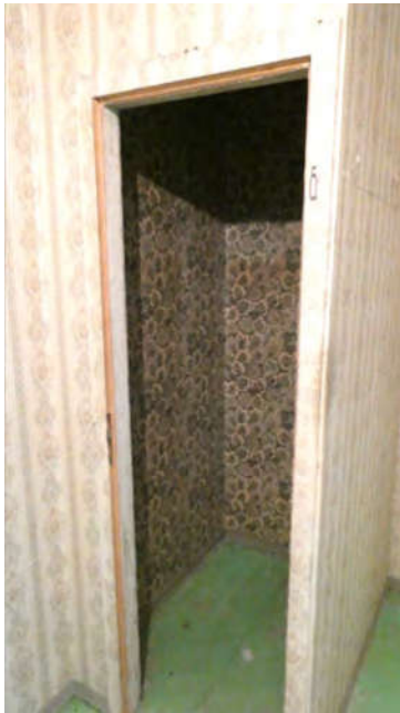
Bild 17: Flur: Abstellkammer / Garderobe Situation Fußboden
