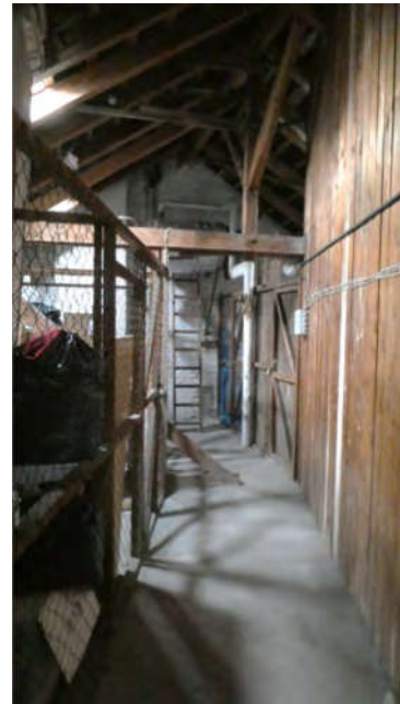
Bild 42: Bereich Dachgeschoss Abstellräume
