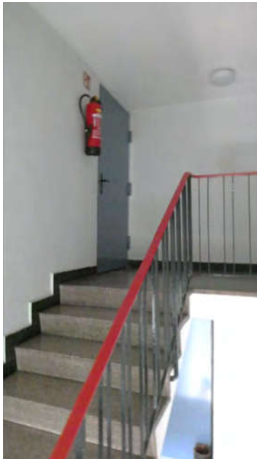
Bild 41: Bereich Treppenhaus / Dachgeschoss (Abstellräume)
