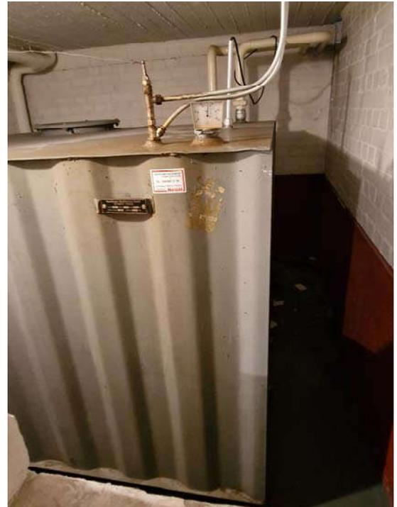
... Ölzentralheizungsanlage (Bauj. 1968, Hersteller: Buderus, Logana Quell mit zentraler Warmwasserbereitung und Rippenheizkörper und kellergeschweißtem Öltank als Innentank mit 5.000 l Fassungsvermögen
