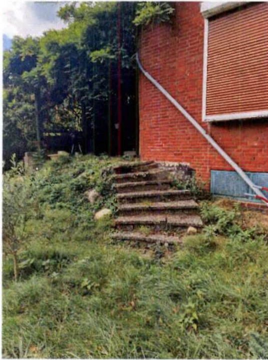
Bild 9: rückwärtige Gartenfläche (Außenanlagen)
