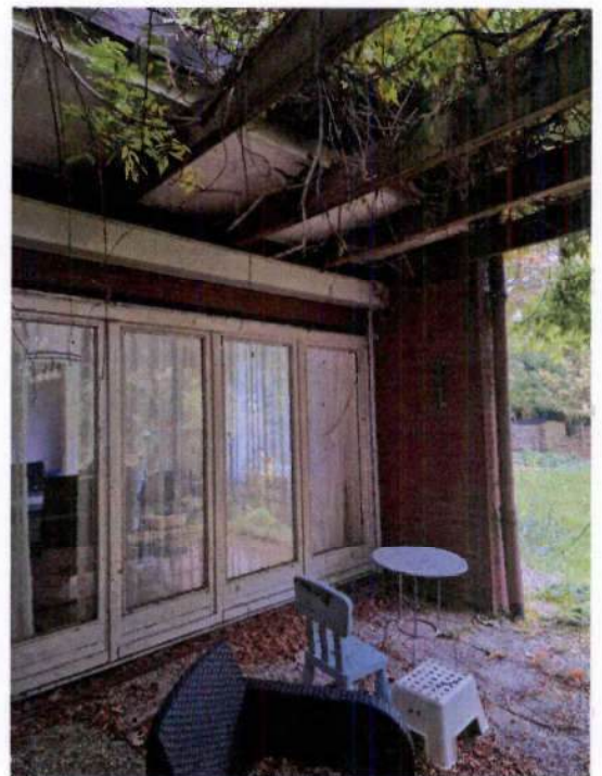
... und Terrasse mit Betonplattenbelag und Pergola-Überdachung [hölzerne Pfosten-Riegel-Konstruktion]
