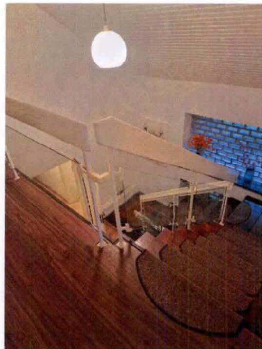
... und Metalltreppe (als Podesttreppe) zum Dachgeschoss
