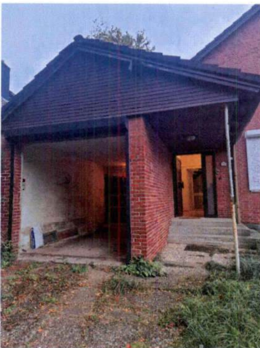
... Zufahrt zur Kfz-Kleingarage
