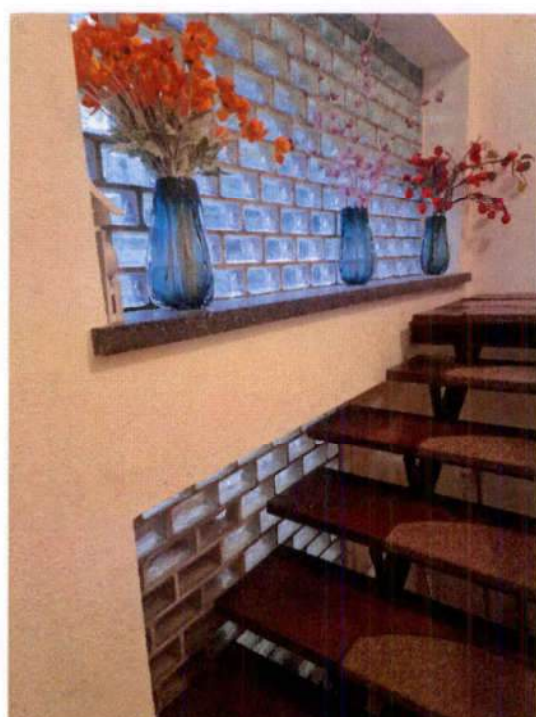
... Glasbausteinwand (nach Norden) zur Beleuchtung
