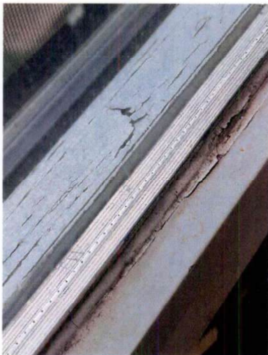
... Holzfenster mit Doppel-Isolierverglasung
