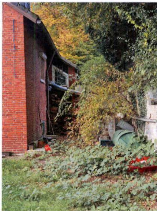
Bild 8: rückwärtige, überdachte Lagerfläche
