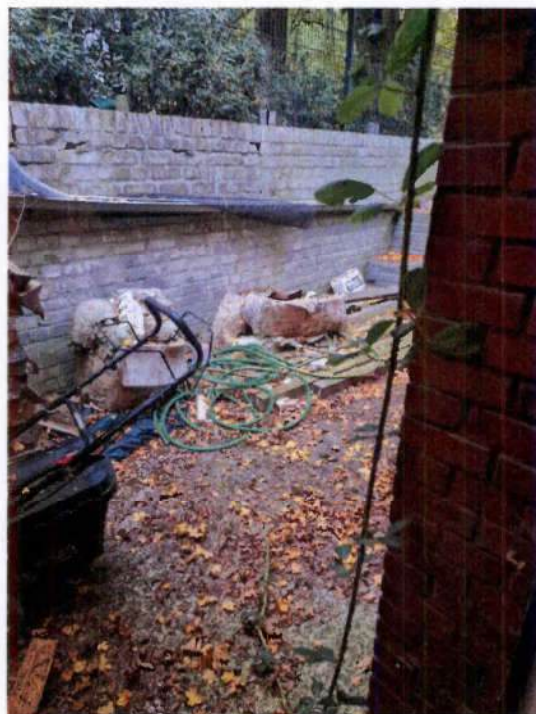
... sowie Mauerwerkswand als grenzständiges Bauteil zum nördlichen Grundstücksnachbarn
