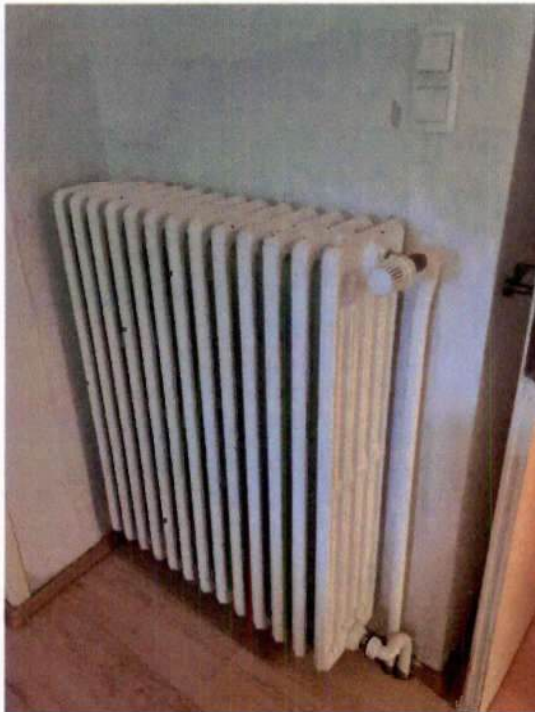
... Überwiegend Rippenheizkörper
