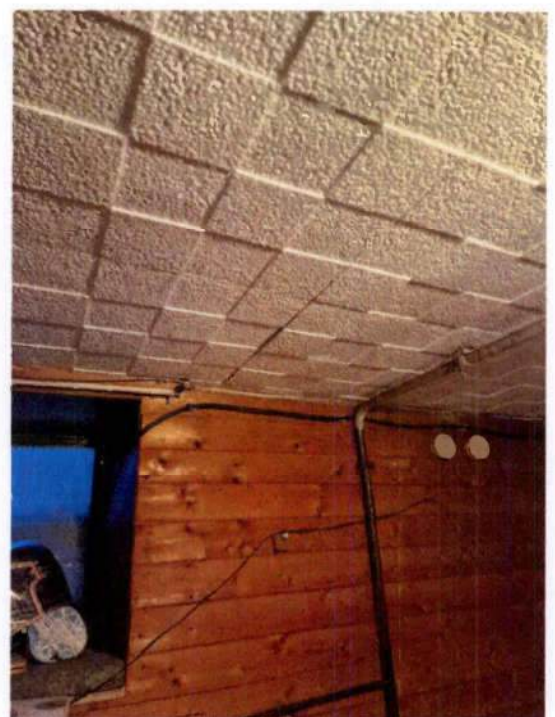
...sowie mit z.T. Polystyrol-Dämmplatten im Keller
