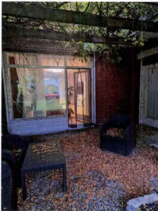
... und Terrasse mit Betonplattenbelag und Pergola-Überdachung [hölzerne Pfosten-Riegel-Konstruktion]
