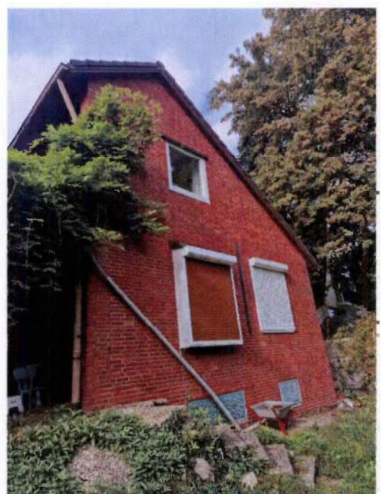
Bild 4: Holz-Geräte-Schuppen (Gesondertes Bauteil)
