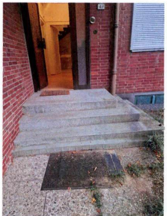
... sowie Hauseingangsbereich mit Treppenpodest
