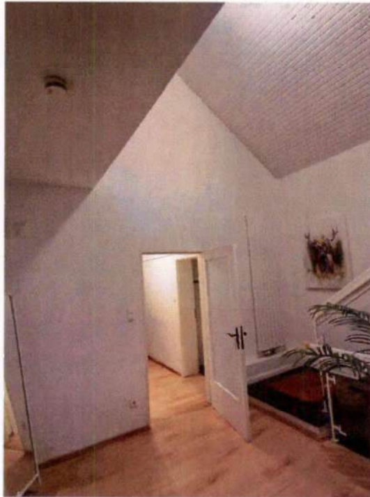
... mit z.T. hölzernen Paneelelementen
