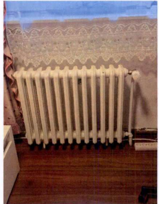
... Überwiegend Rippenheizkörper
