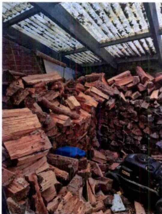
... als hölzerne Pfosten-Riegel-Konstruktion mit Lichtwellplatteneindeckung
