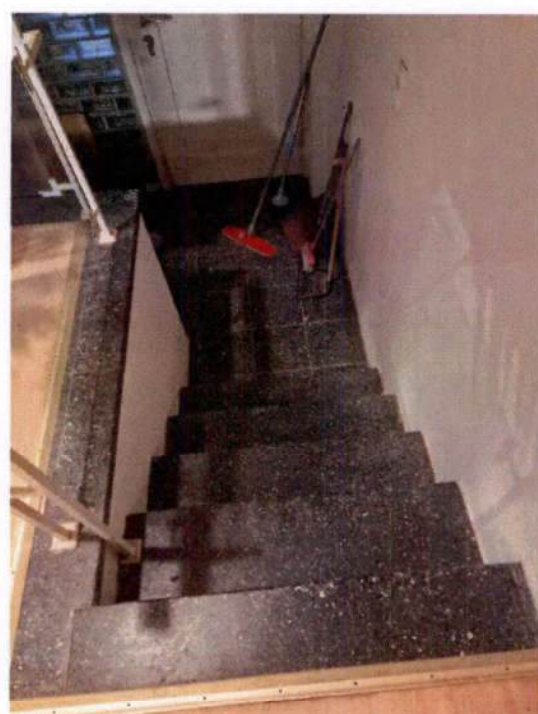
... Kellertreppe (Massiv) mit Werksteinbelag
