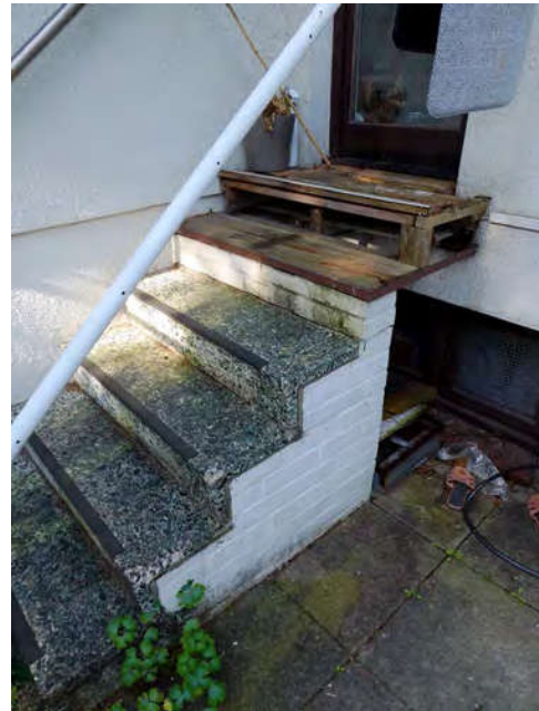
Bild_22 Situation rückwärtige Treppe (Küche)
