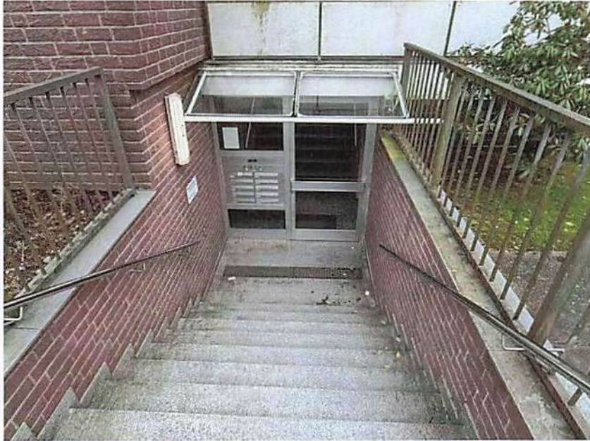
Detail Hauseingang Nr. 2
