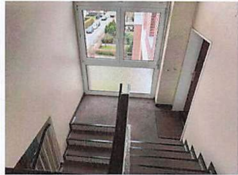
Treppenhaus mit Detail Fenster
