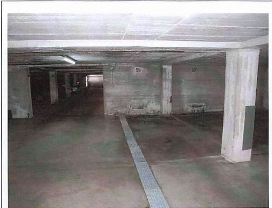
Tiefgarage mit Platz Nr. 58
