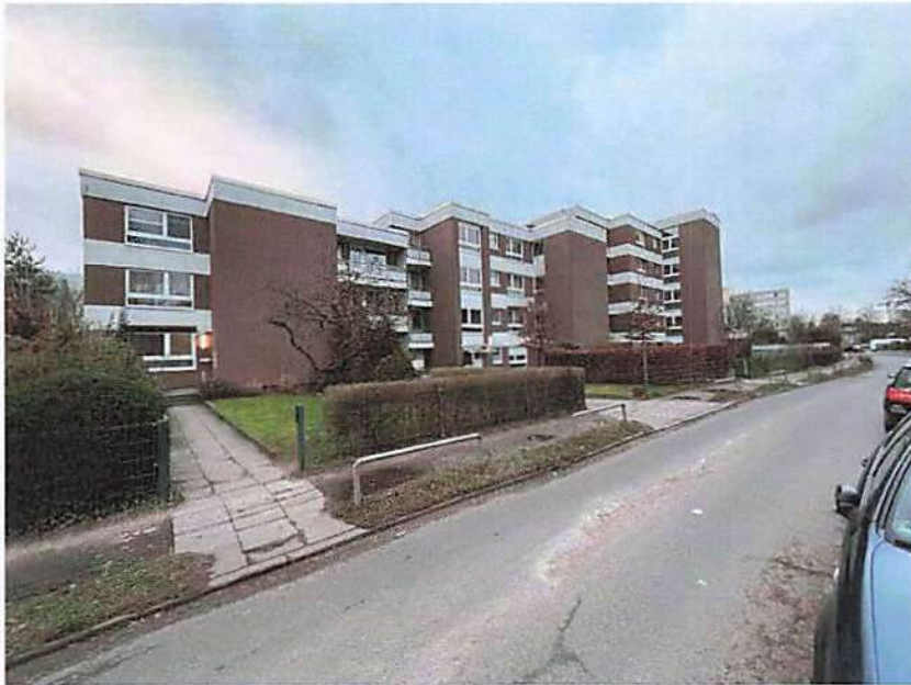
Görlitzer Straße vor dem Haus
