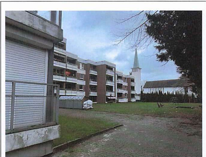
Teilansicht Rückseite mit Tiefgarage und Müllcontainer
