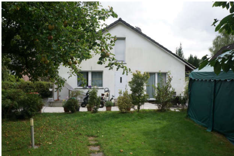
Ansicht Rückseite Norden mit Terrasse
