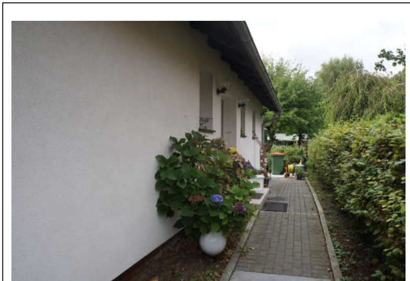
Zuwegung zum Hauseingang auf der Ostseite
