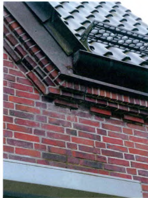
Bild 70: Situation Bereich Fassade rückwärtig, Feuchtigkeitsschaden
