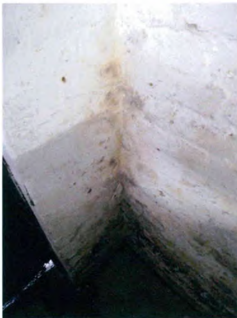
Bild 59: Garage Feuchtigkeitsschaden
