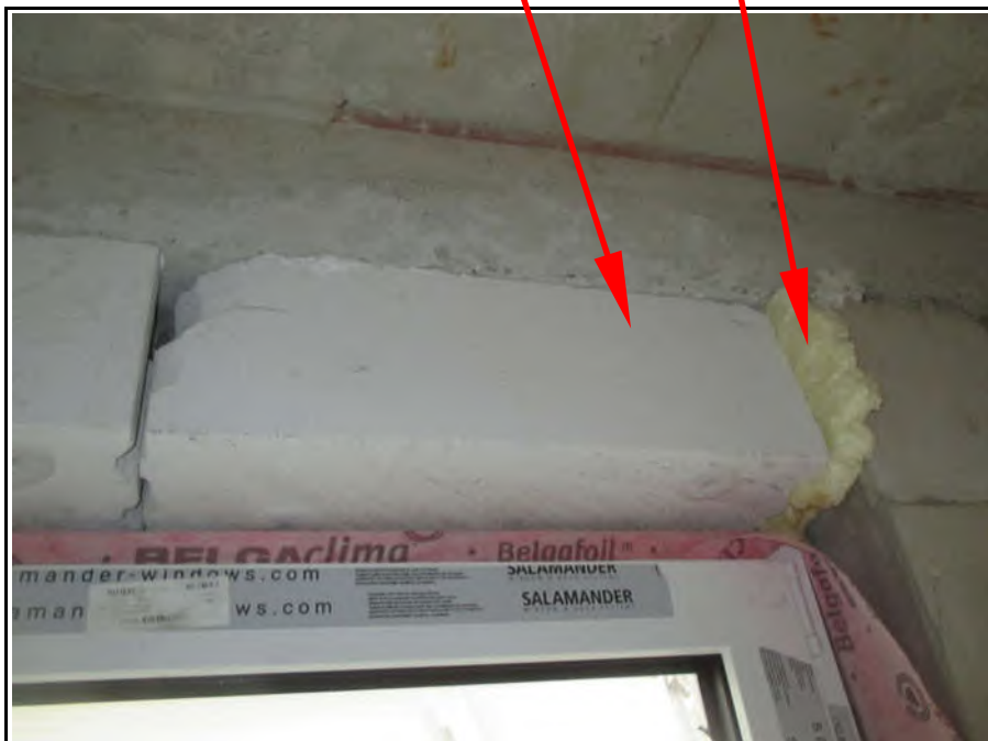
Bild 14 (provisorische Ausmauerung Fenstersturz, ausgeschäumt)
