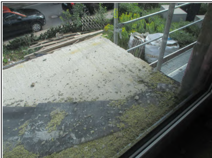
Bild 16 (Ansicht auf Balkonkragplatte im OG vorne)
