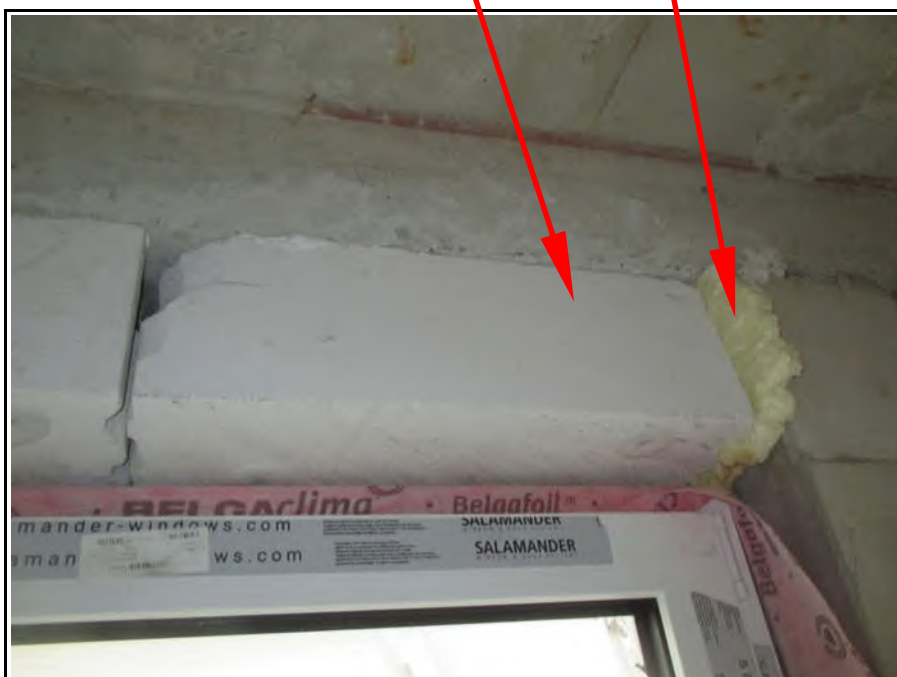
Bild 14 (provisorische Ausmauerung Fenstersturz, ausgeschäumt)
