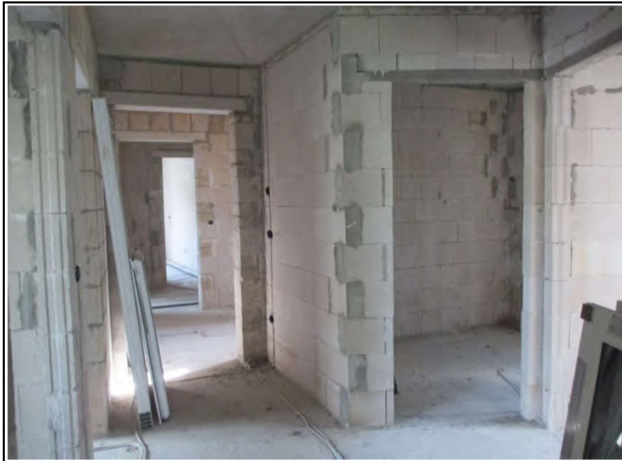
Bild 17 (Beispiel Flur Wohnung IV im OG hinten)
