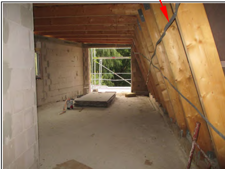
Bild 28 (Wohnraum Staffelgeschoss hinten / Windrispen wellig)
