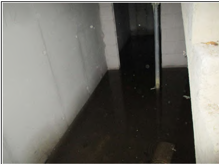
Bild 10 (Blick in den Keller, hier steht Wasser)
