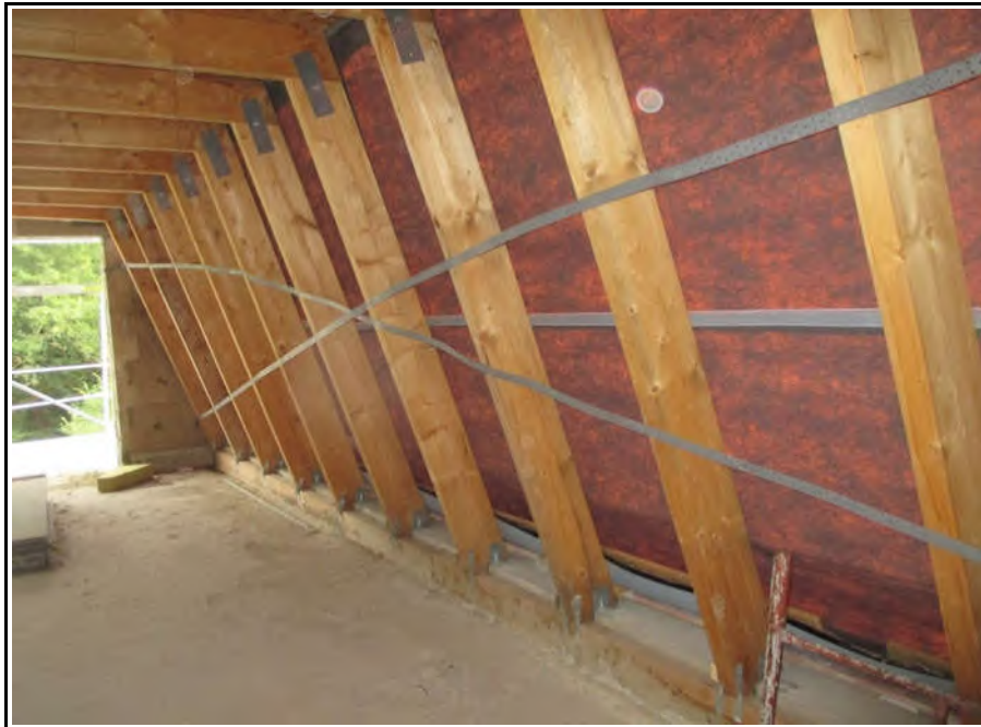
Bild 27 (Dach innen / Windrispen)
