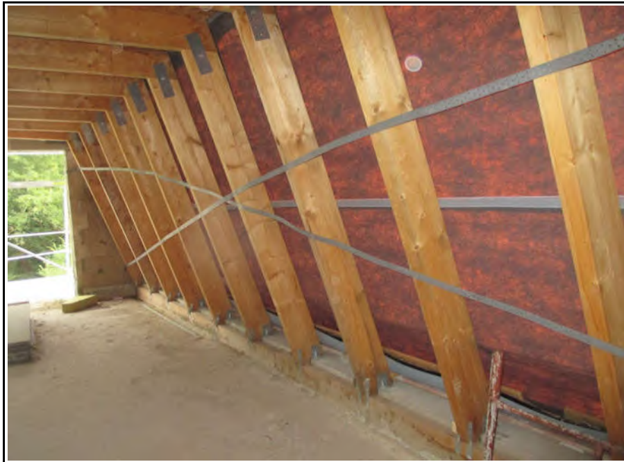
Bild 27 (Dach innen / Windrispen)
