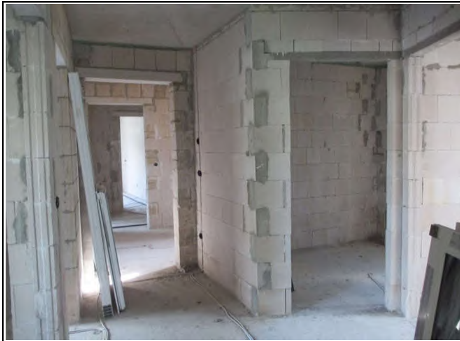
Bild 17 (Beispiel Flur Wohnung IV im OG hinten)
