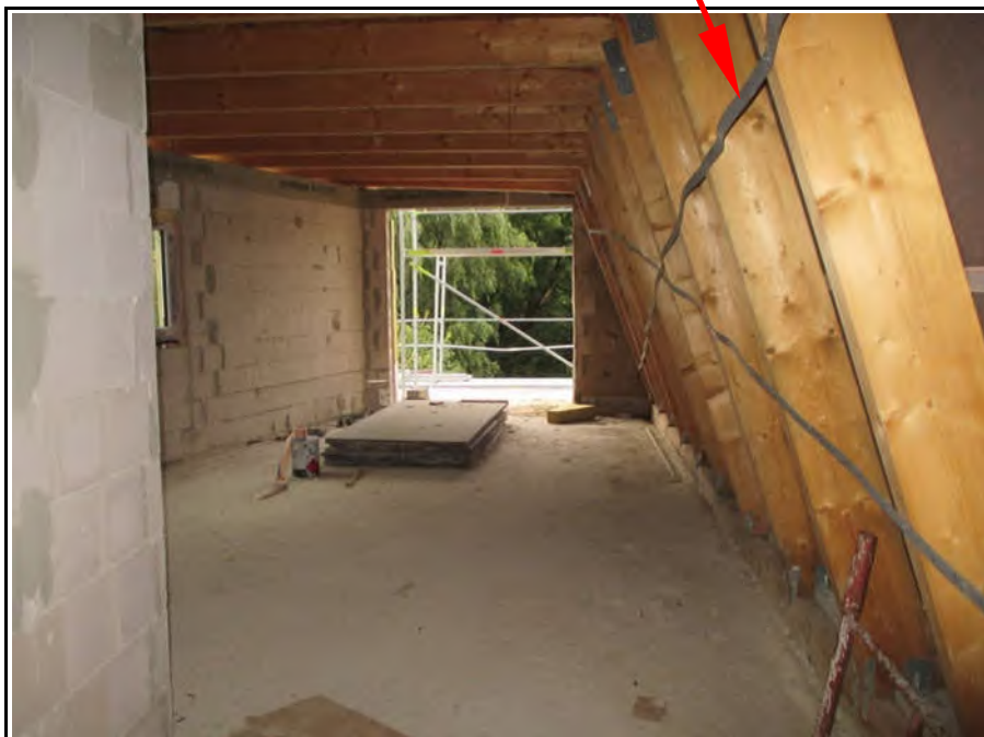
Bild 28 (Wohnraum Staffelgeschoss hinten / Windrispen wellig)
