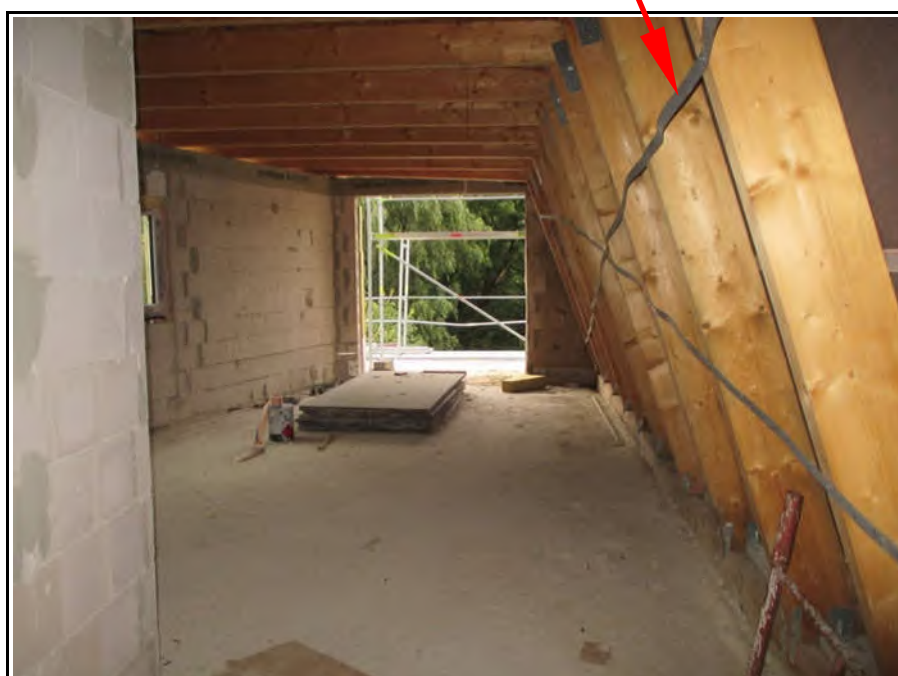
Bild 28 (Wohnraum Staffelgeschoss hinten / Windrispen wellig)
