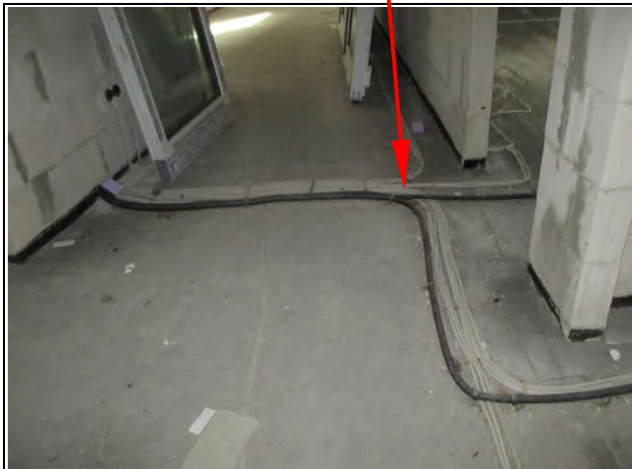
Bild13 (Elektroleitungen sind überwiegend vorhanden)
