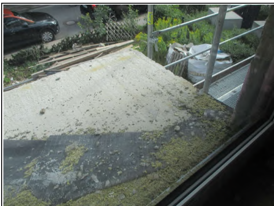
Bild 16 (Ansicht auf Balkonkragplatte im OG vorne)
