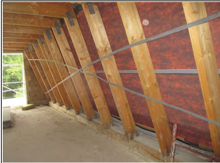
Bild 27 (Dach innen / Windrispen)
