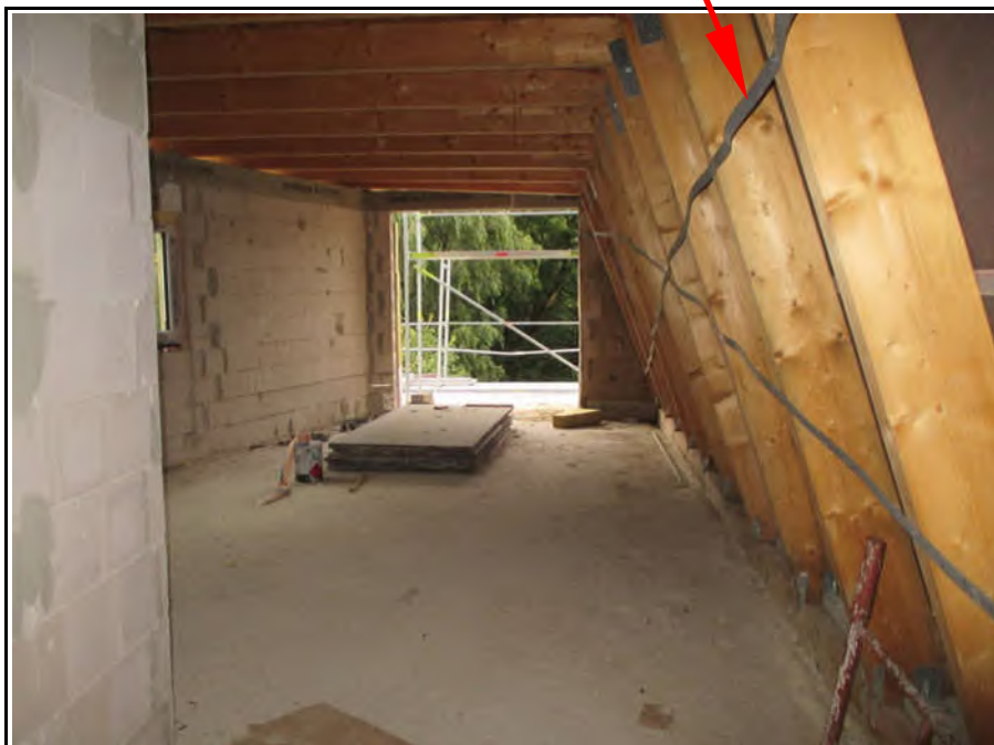
Bild 28 (Wohnraum Staffelgeschoss hinten / Windrispen wellig)
