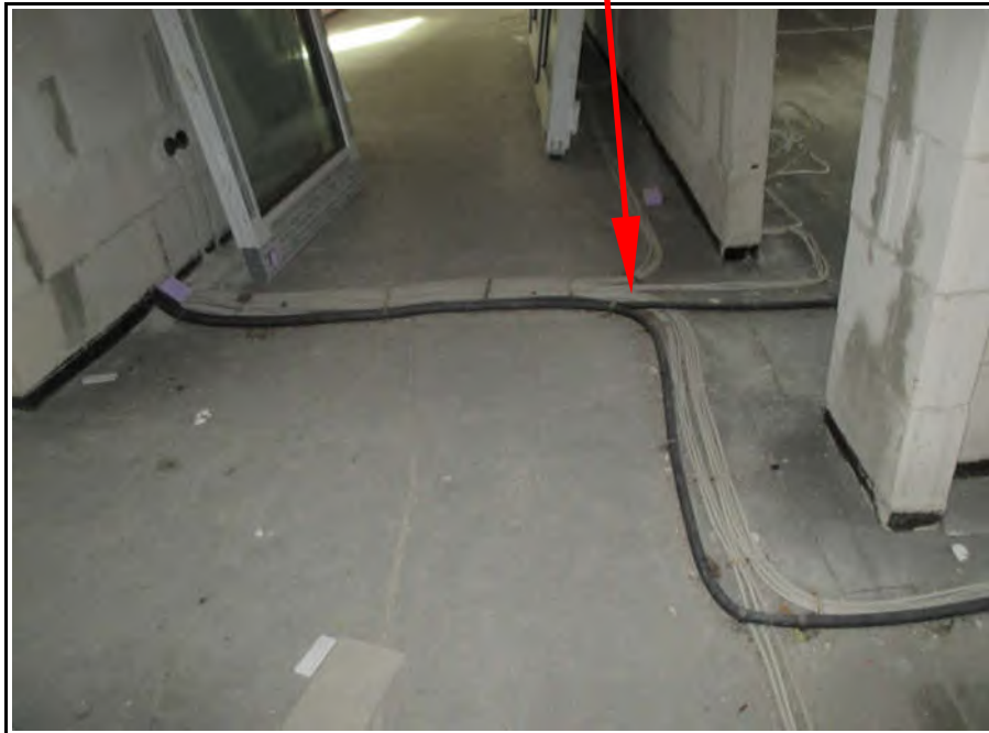
Bild13 (Elektroleitungen sind überwiegend vorhanden)
