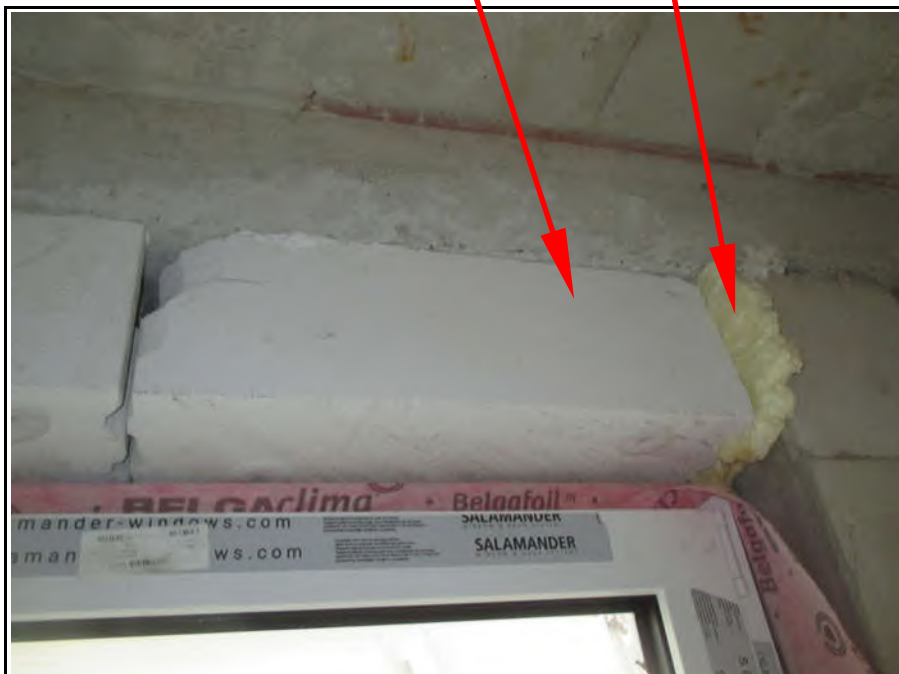
Bild 14 (provisorische Ausmauerung Fenstersturz, ausgeschäumt)
