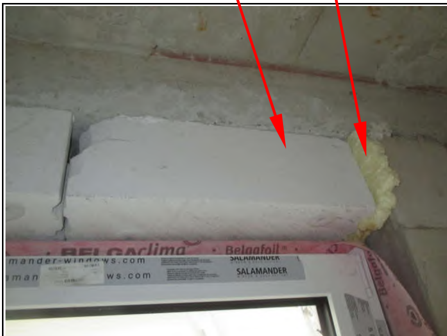
Bild 14 (provisorische Ausmauerung Fenstersturz, ausgeschäumt)
