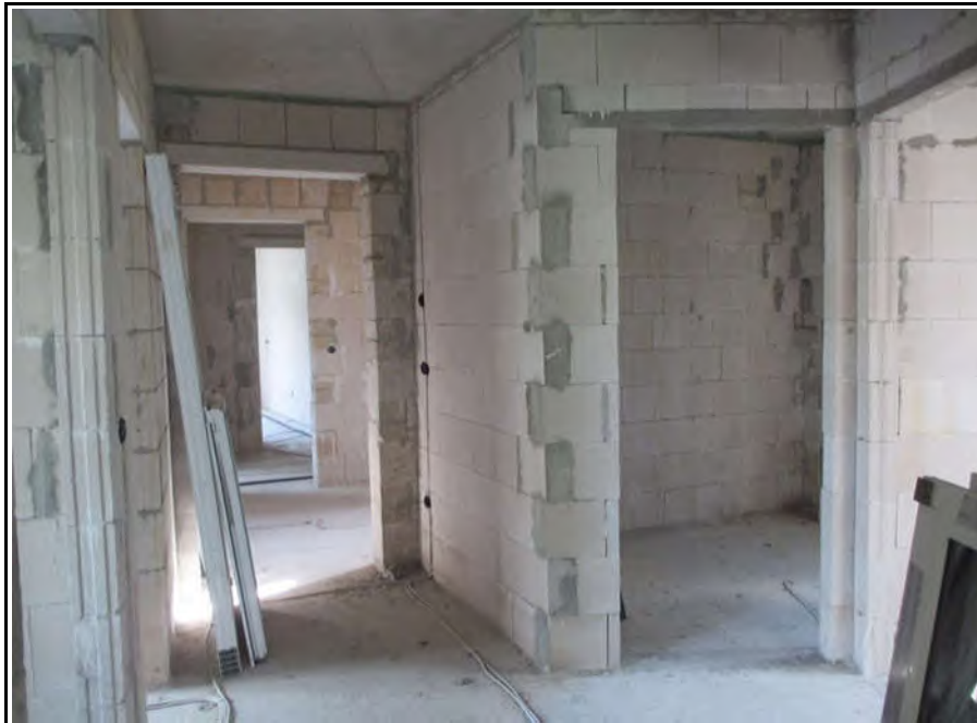
Bild 17 (Beispiel Flur Wohnung IV im OG hinten)
