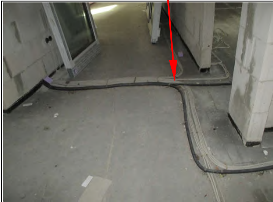
Bild13 (Elektroleitungen sind überwiegend vorhanden)
