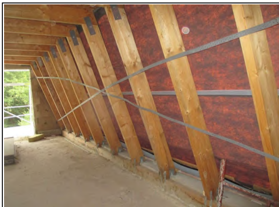
Bild 27 (Dach innen / Windrispen)
