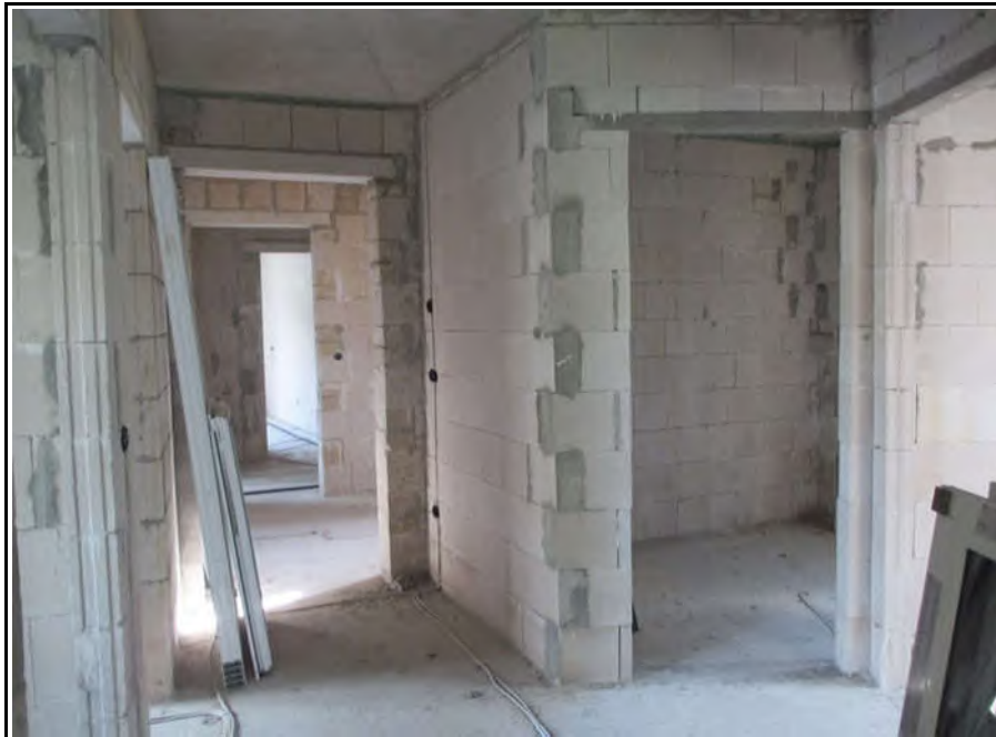
Bild 17 (Beispiel Flur Wohnung IV im OG hinten)
