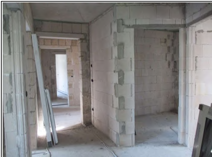
Bild 17 (Beispiel Flur Wohnung IV im OG hinten)
