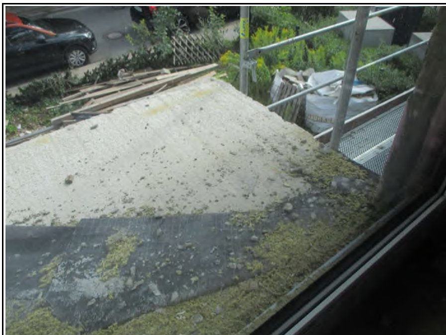
Bild 16 (Ansicht auf Balkonkragplatte im OG vorne)
