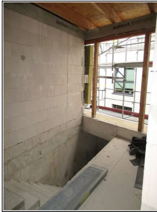
Bild 19 (Treppenhaus im Staffelgeschoss)
