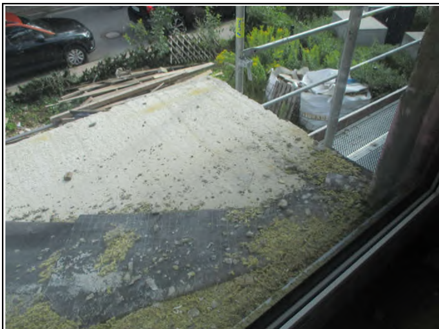
Bild 16 (Ansicht auf Balkonkragplatte im OG vorne)
