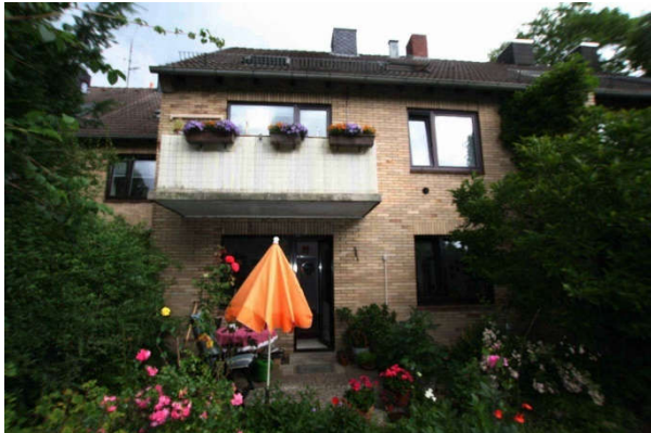
Gebäuderückseite mit Terrasse im EG
