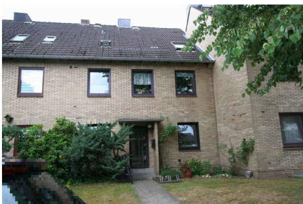
Eingangsbereich für EG und OG (Ostseite)
