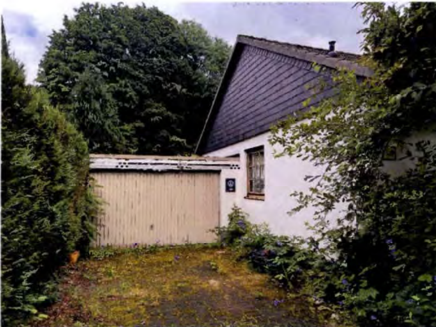
Gebäudeseite links und Garage
