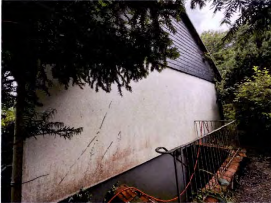
Gebäudeseite rechts mit Kelleraußentreppe
