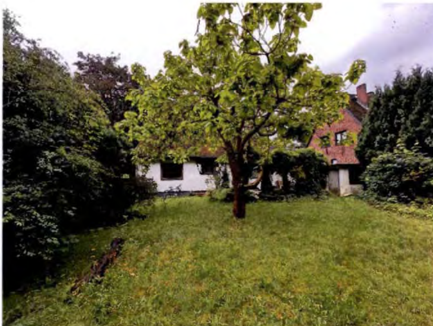
Gebäuderückseite mit Garage
