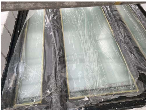
Detail Fenster Hochparterre
