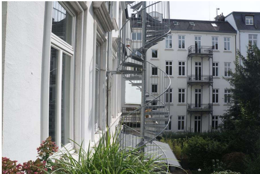
Rückfassade vom Nachbarhaus aus mit gemeinsamer Nottreppe
