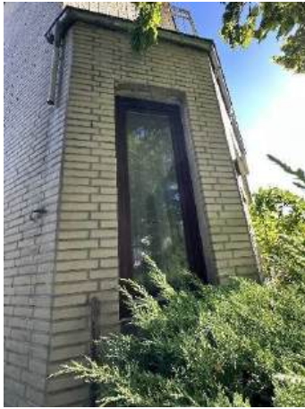
Vorbau - nördliche Seite
