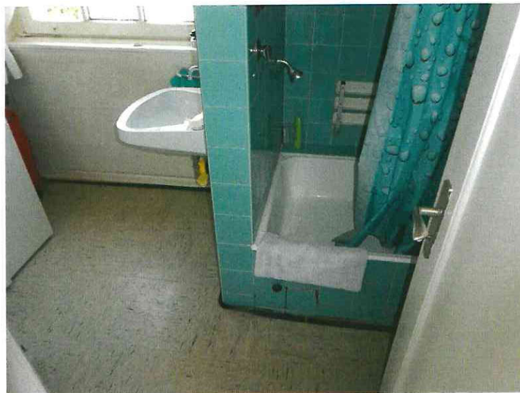
Bild 23: Sanitäre Ausstattung Wohnung Obergeschoss
