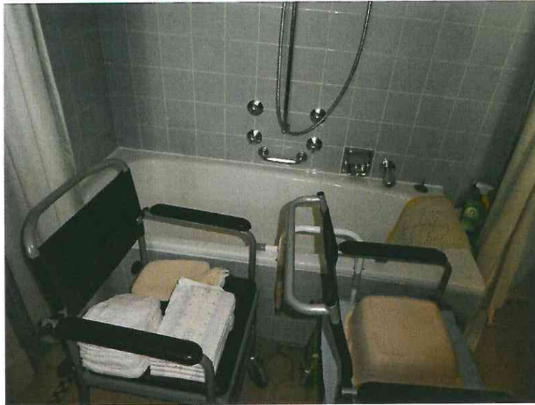
Bild 22: Sanitäre Ausstattung Wohnung Obergeschoss
