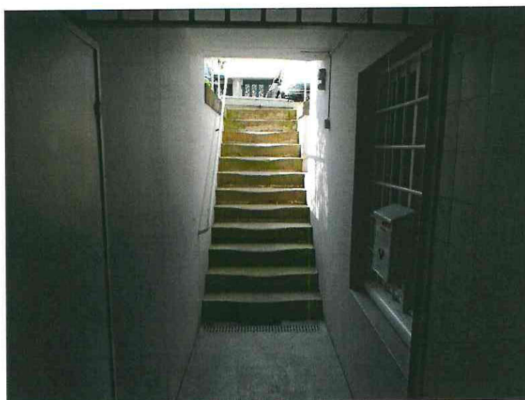
Bild 20: Zugang Keller und Kellerwohnung
