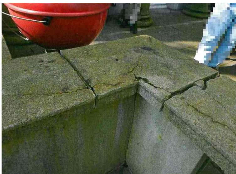
Bild 36: Schäden Terrasseneinfassung
