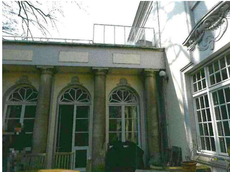
Bild 11: Anbau des Gartenzimmers
