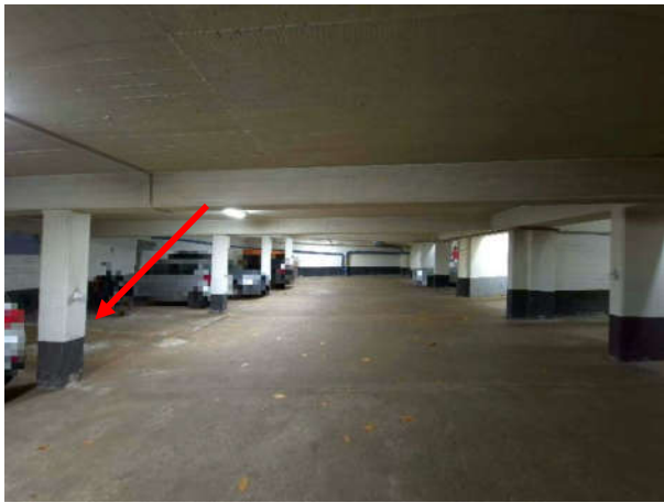
Hauptteil der Tiefgarage „rechts der Einfahrt“
