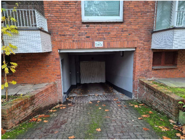
Tiefgaragenzufahrt von der Meißnerstraße (Außen)
