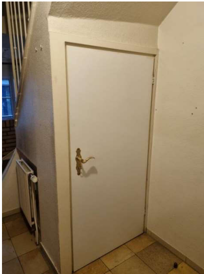
Zugang zum Keller vom Flur aus
