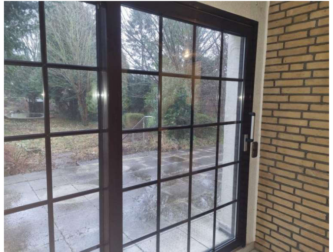
Detailansicht Schiebetür zur Terrasse / zum Garten
