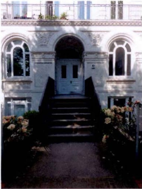
Bild 13: Bereich Haupteingang Gebäude
