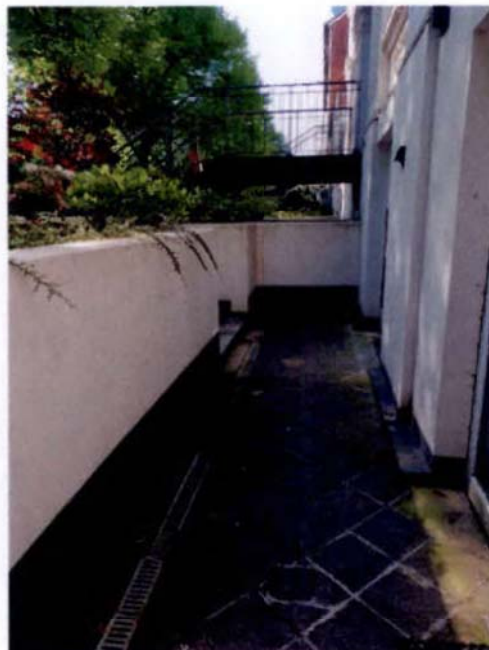
Bild 20: Bereich vor dem Zugang Teileinheit Nr. 3 Laden
