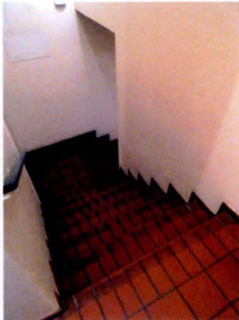
Bild 18: Bereich Treppenhaus / Untergeschoss
