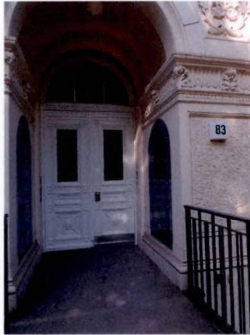
Bild 14: Bereich Haupteingang Gebäude
