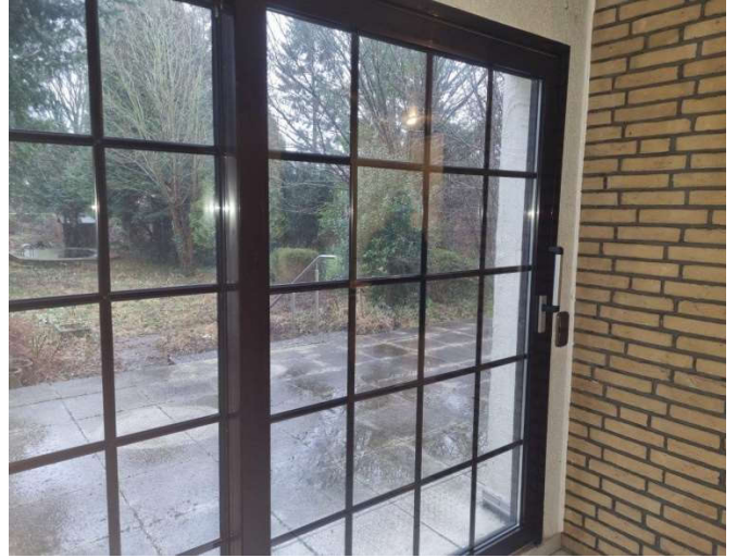
Detailansicht Schiebetür zur Terrasse / zum Garten
