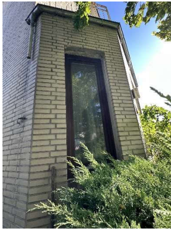
Vorbau - nördliche Seite
