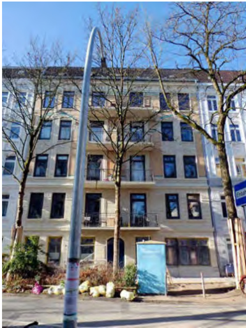
Bild 5: Ansicht von der Straße
