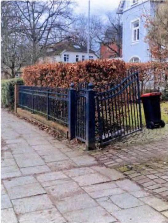
**Bild 13:** Metallzaunanlage auf niedrigem Mauerwerkssockel und Heckenanpflanzung
