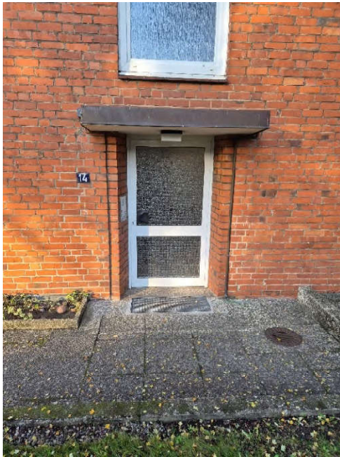
Hauseingangstür von außen
