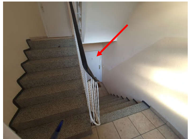
Treppenhaus mit Wohnungseingangstür Wohnung Nr. 8
