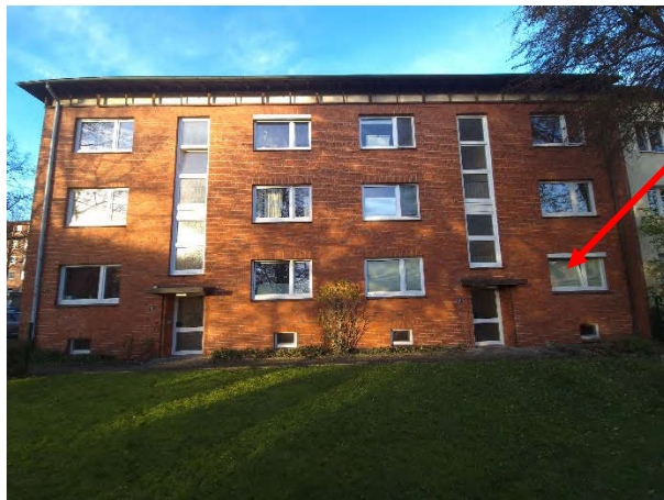
Gebäudevorderseite von der Gartenseite (Osten) mit den Hauseingängen Nr. 12 und Nr. 14
