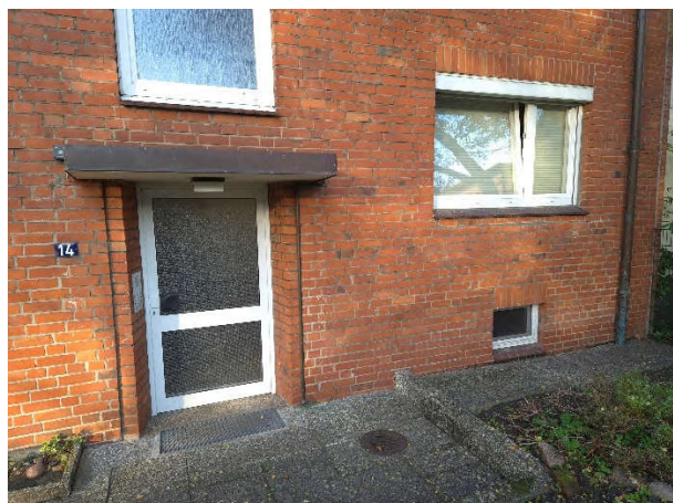
Hauseingang Nr. 14 (Osten)
