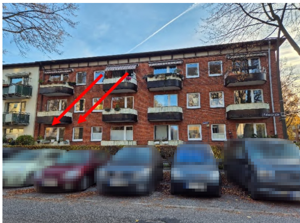
Gebäuderückseite von der Faberstraße (Westen)
