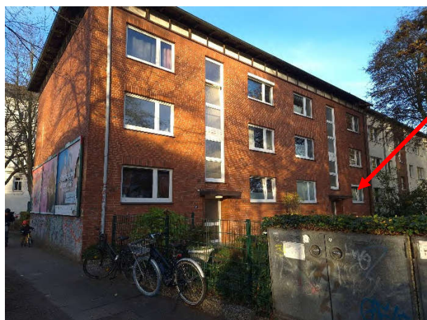
Gebäudeecke zum Spengelweg (Südosten)
