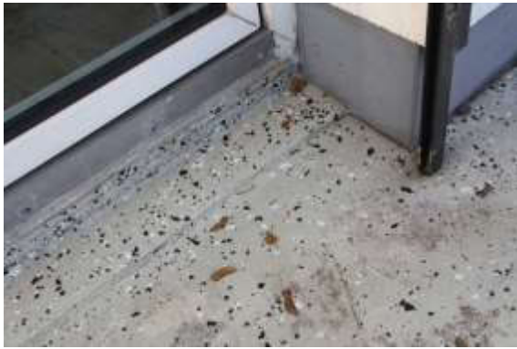
Risse und Unebenheiten auf dem Balkonboden
