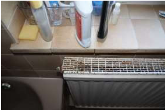
Obergeschoss: Badezimmer, Heizkörper
