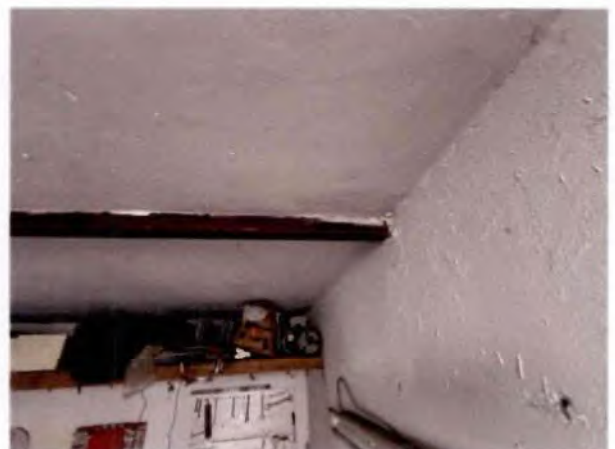
6typischer Dachträger mit Rostschaden
