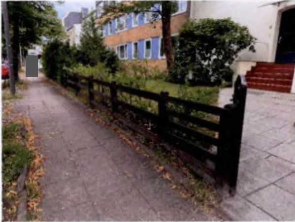
Einfriedung – Querlatten fehlen
