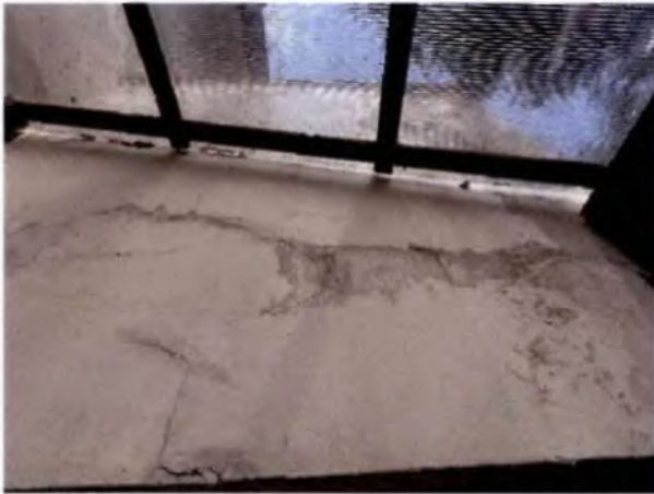
Balkon – Außenwand mit Feuchteschäden
