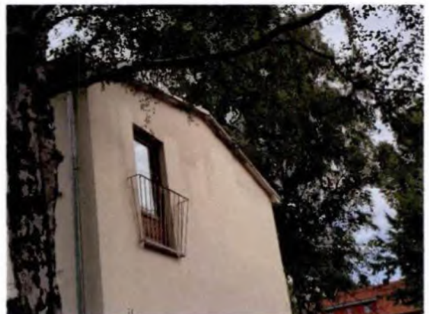
Giebelseite Dachüberstand morsch, Wand feucht
