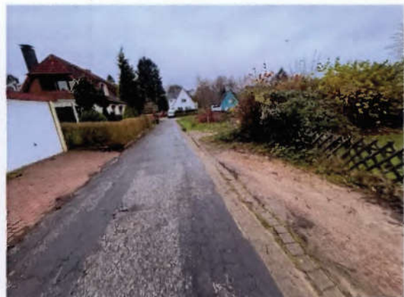
Blick entlang der Straße Keustück
