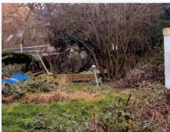
Mauerwerk im hinteren Grundstücksbereich
