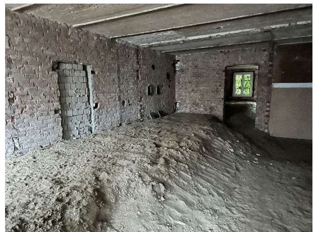
Fahrrad-Kinderwagenraum Bereich für Kellerabstellräume 1 bis 3
