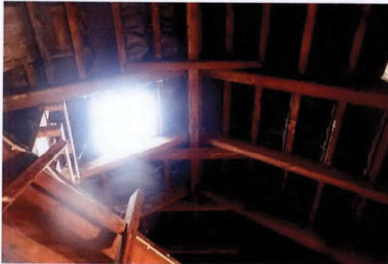
Bild 14: nicht gedämmte Dachfläche
