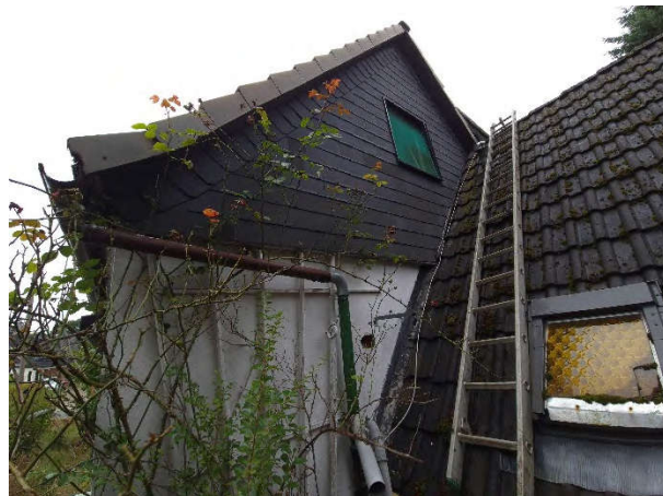
Gebäuderückseite mit ehemaligem Stallgebäude (Südgiebel)
