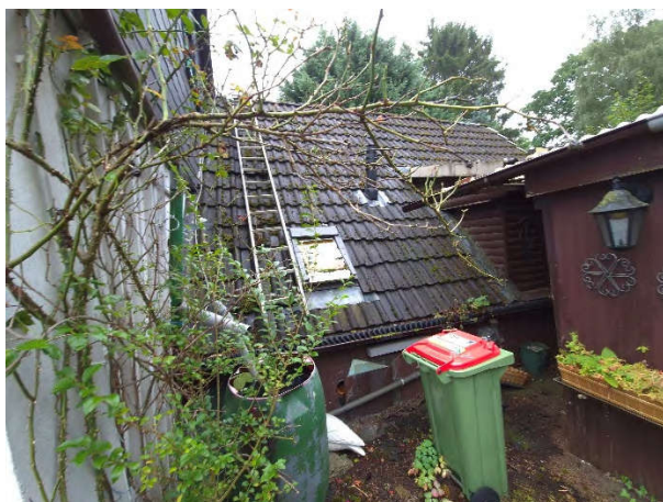
Stallgebäude (Westseite) mit Schuppen
