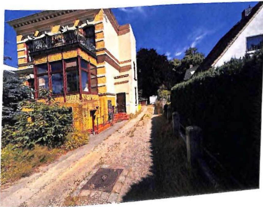
Zufahrt seitlich am Gebäude
