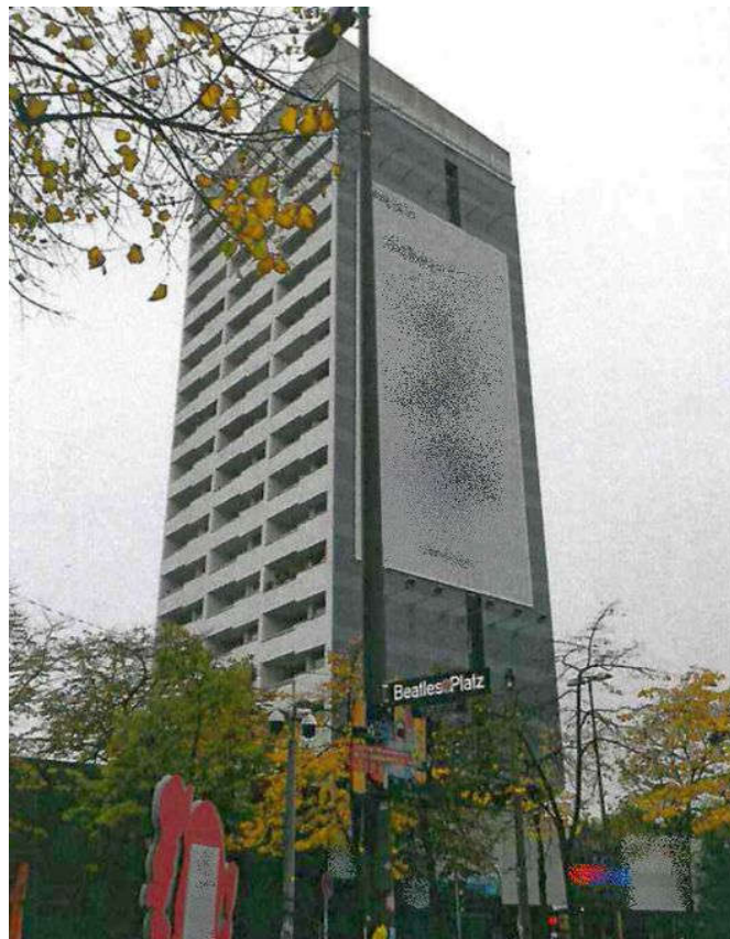
Bild 2: Straßensicht aus Nordosten
