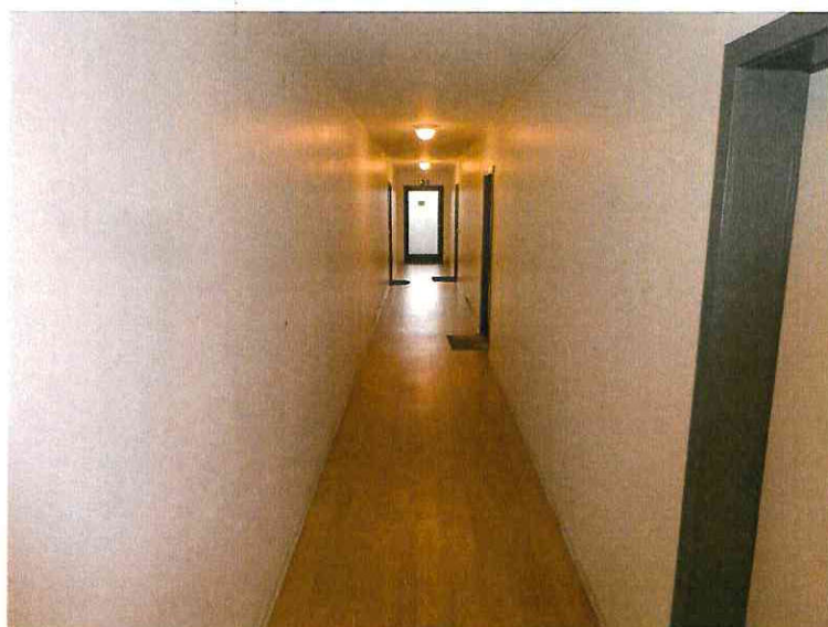
Bild 16: Treppenhausflur im 7. Obergeschoss
