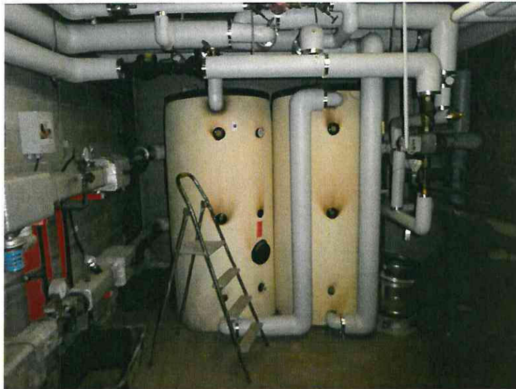
Bild 8: Warmwasseraufbereitung
