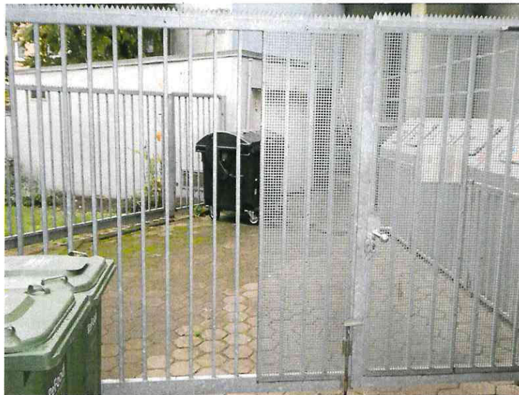
Bild 20: Mülltonnen im südlichen Grundstücksbereich
