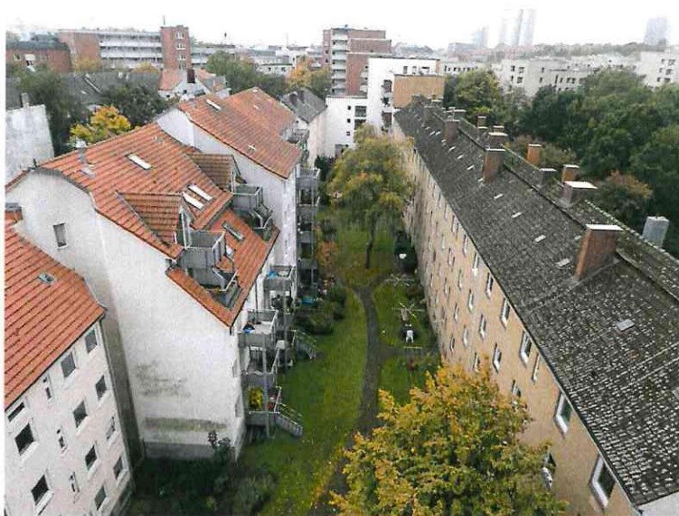
Bild 18: Blick aus dem Treppenhaus im 7. OG. in südlicher Richtung
