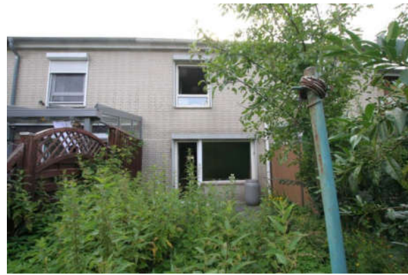
Rückseite Reihemittelhaus (Westen)
