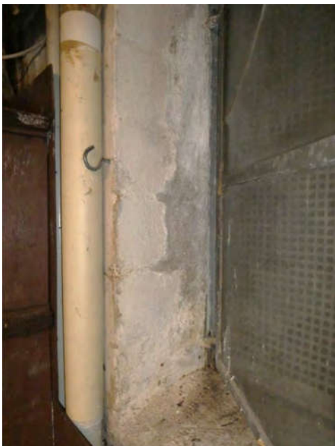
Bild 43: Situation Feuchtigkeitsschaden
