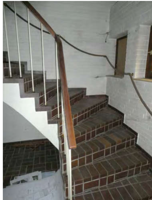
Bild 50: Souterrain Treppe in das EG
