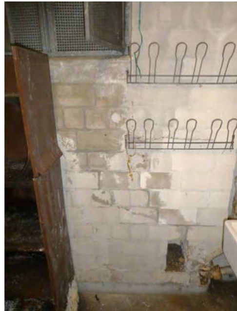
Bild 42: Situation Souterrain Keller Heizungsanlage
