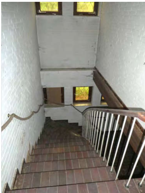
Bild 51: EG Treppe in den Souterrain
