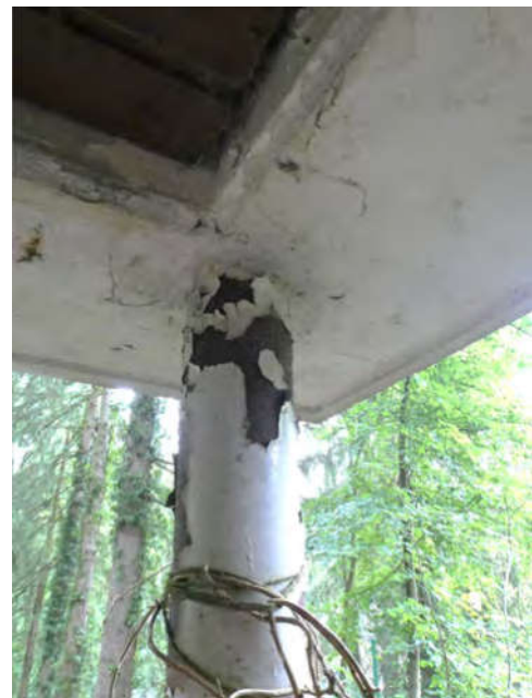
Bild 81: Situation Eingangsbereich Stütze
