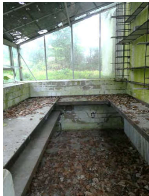
Bild 16: Blick in den Wintergarten o.ä.
