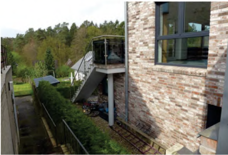
13. Treppe an nördlicher Grundstücksgrenze
