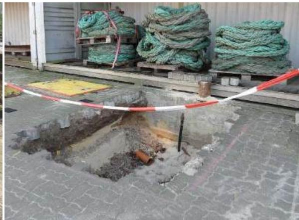
Aufgrabungen wegen defekter Wasserleitungen vor Container-Lärmschutzwand
