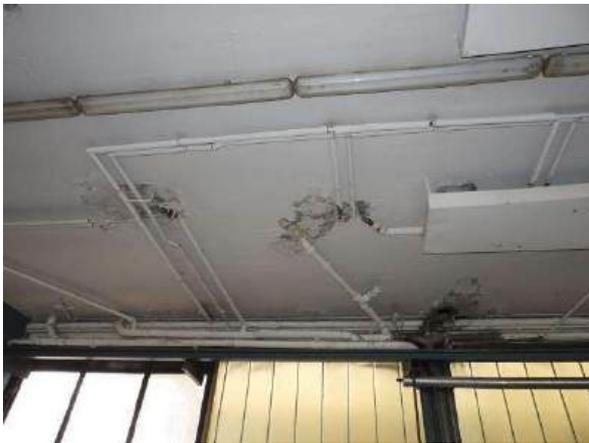
diverse Feuchteschäden an der Erdgeschossdecke
