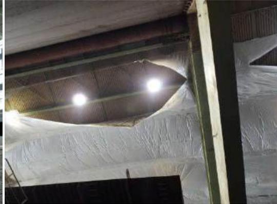
Dachfläche undicht, in der Folie steht Wasser
