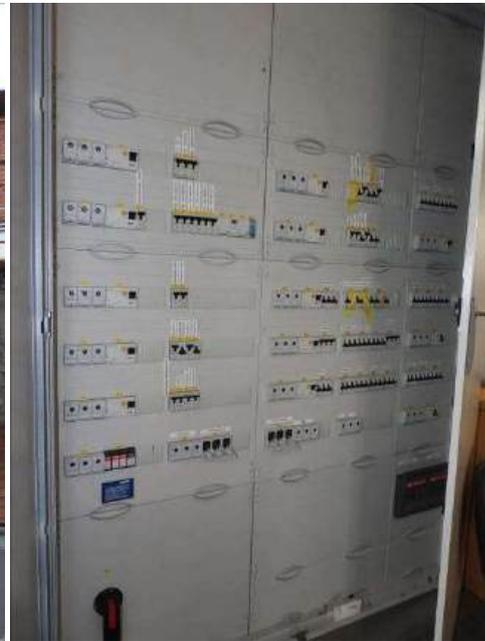
Elektro-Sicherungskasten mit Kippsicherungen
