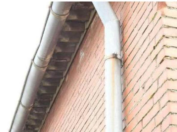
Dachrinne schadhaft, Fugen vermoost, Wellasbestplatten
