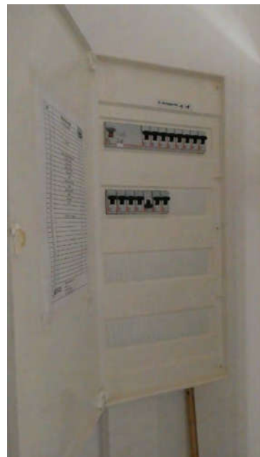
Bild 28: Abstellraum, Situation Elektrik
