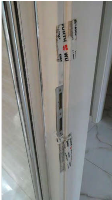
Bild 25: Bad , Situation Türrahmen
